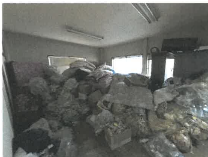
物件 5 2階北東側物置の状況
