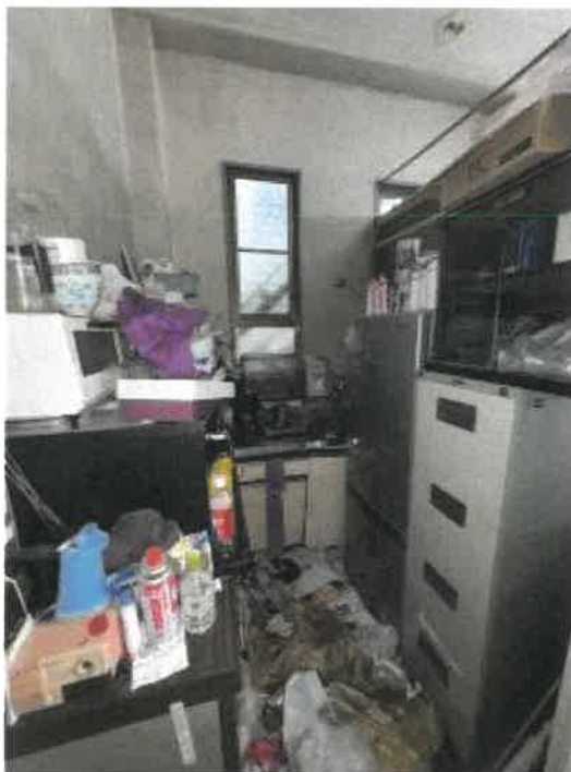
物件6 1階店舗北東側給湯室の状況
