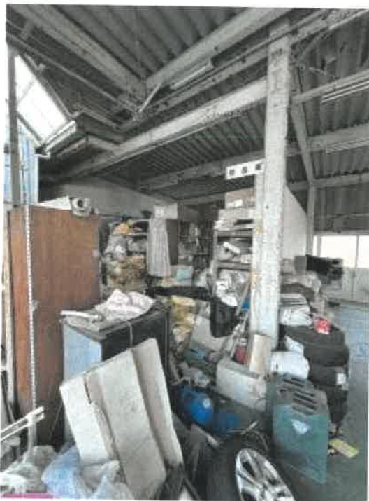
物件 6 未登記附属建物北西側（物置）の状況
