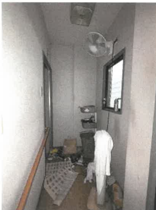
物件6 1階脱衣所の状況
