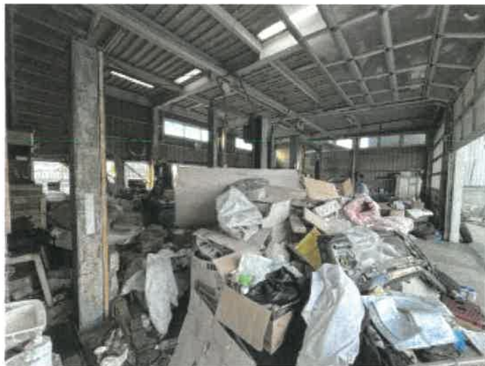
物件 5 1 階作業所の状況
