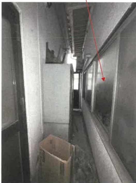
物件6 店舗北側の状況
