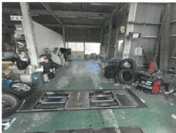
物件 6 未登記附属建物（作業所）の状況
