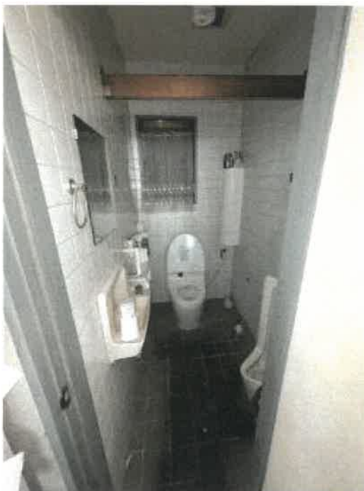
物件6 1階トイレの状況
