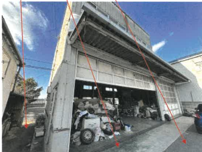
物件 5 南西側の状況
