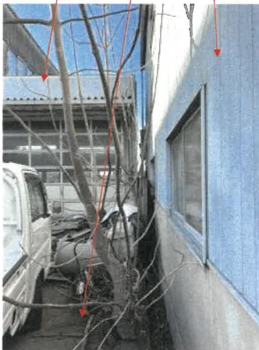
物件 2 西側境界付近の状況
