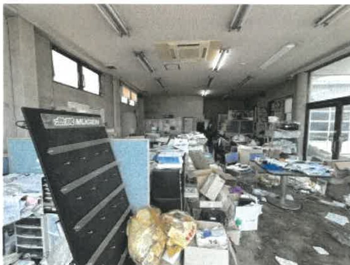
物件6 1階店舗内の状況
