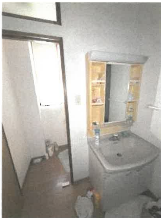
物件2 3階手洗付近の状況
