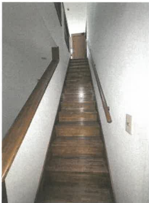
物件 2 階段の状況
