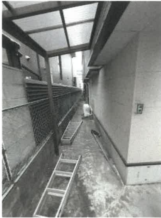
物件1 北東側の状況
