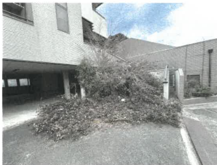
物件1 南側の状況
