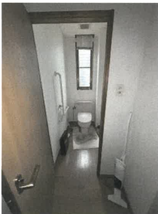
物件 2 2階トイレの状況
