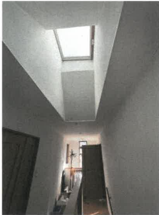
物件2 3階廊下上部の状況
