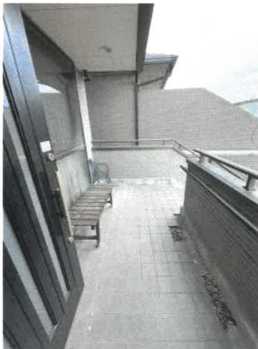
物件2 2階テラスの状況
