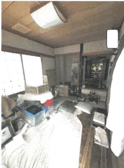
物件 2 2階和室の状況
