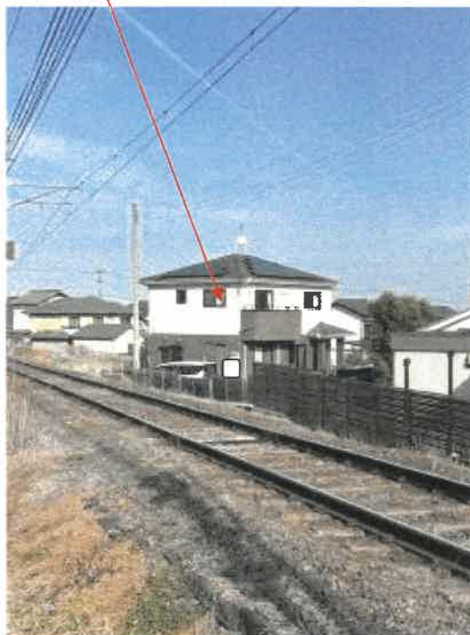
物件 3 北西側の状況
