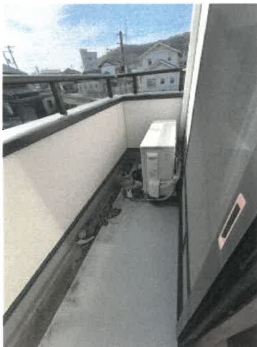
物件3 バルコニーの状況
