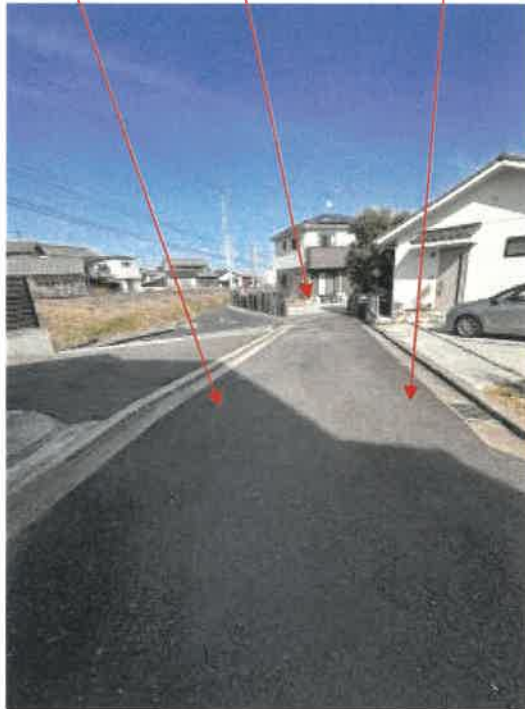
物件 2 西側の状況
