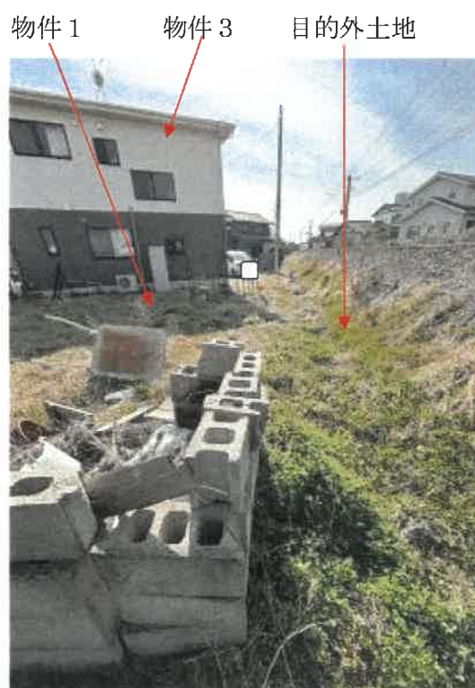
物件 1 北西側の状況
