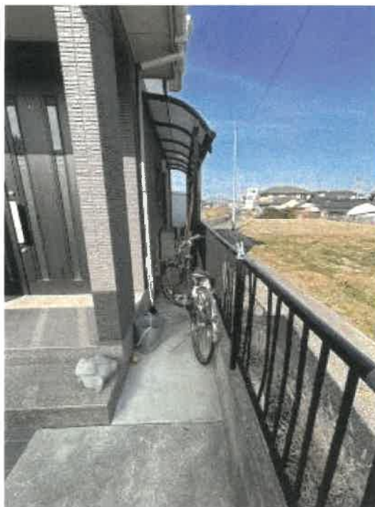
物件3 東側の状況
