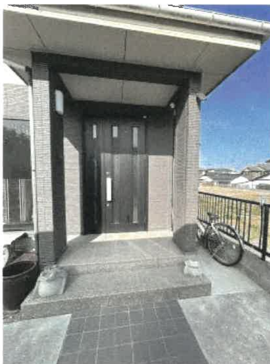
物件3 玄関付近の状況
