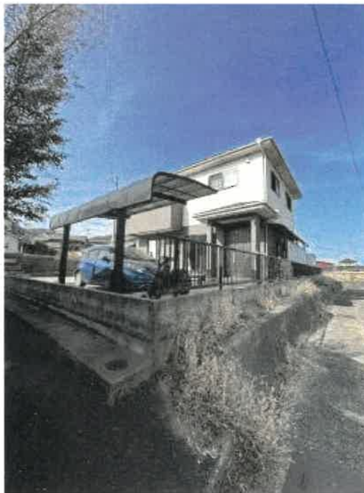
物件1 南東側の状況
