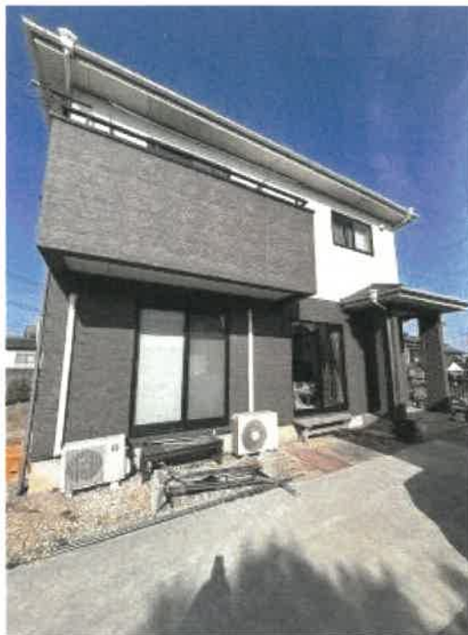
物件 3 南側の状況
