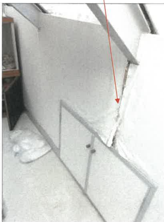
物件 2 建物の 2 階北側広縁の北面壁の状況
