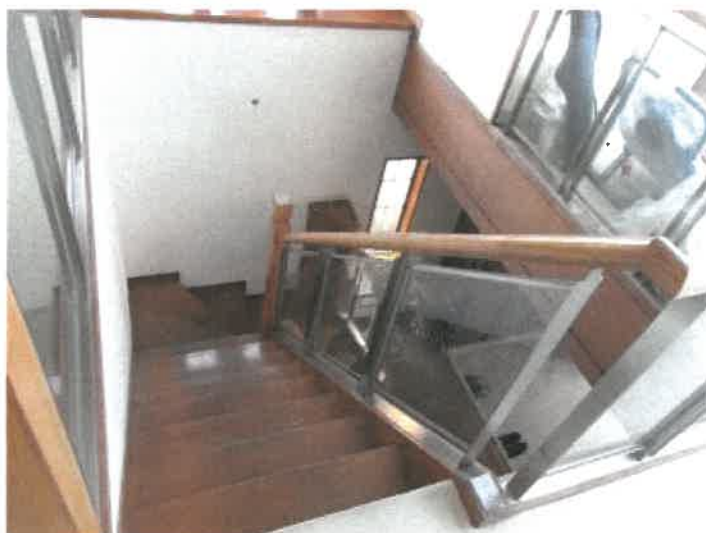
物件 2 建物の 2 階から 1 階への階段の状況
