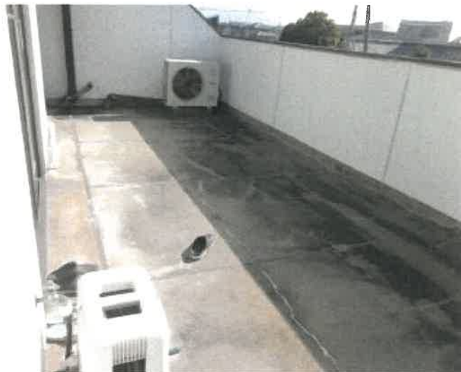
物件2建物の2階南側ベランダの状況
