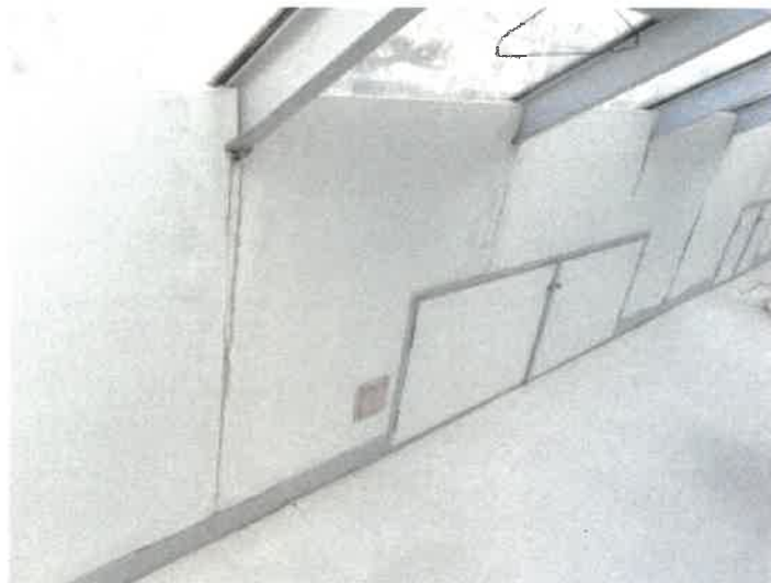
物件 2 建物の 2 階北側広縁の北面壁の状況
