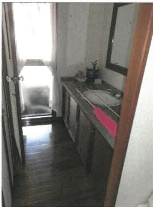
物件2建物の1階トイレ前洗面の状況
