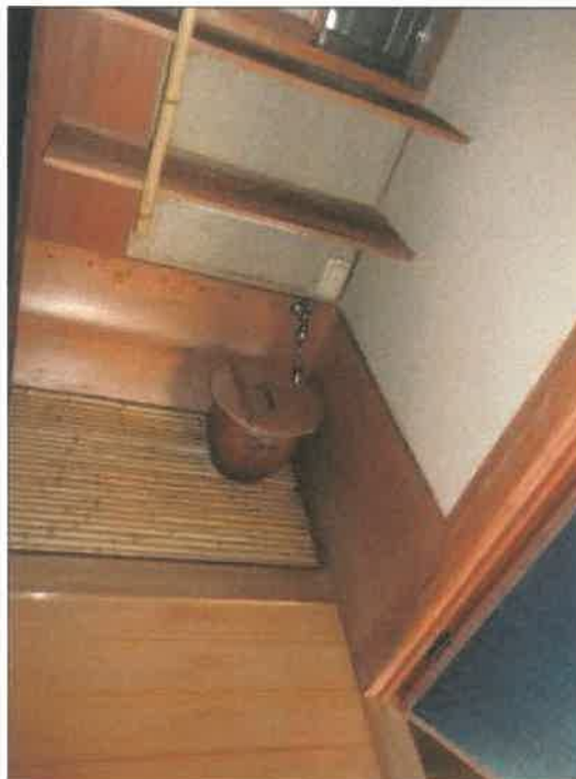
物件 2 建物の 1 階茶室の水屋の状況
