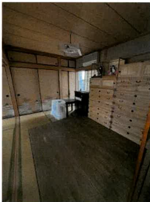
物件2 1階西側和室の状況
