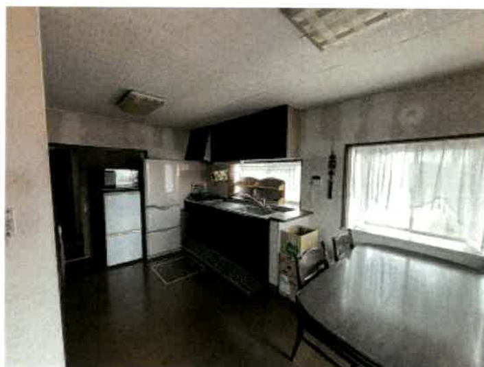
物件2 1階台所の状況
