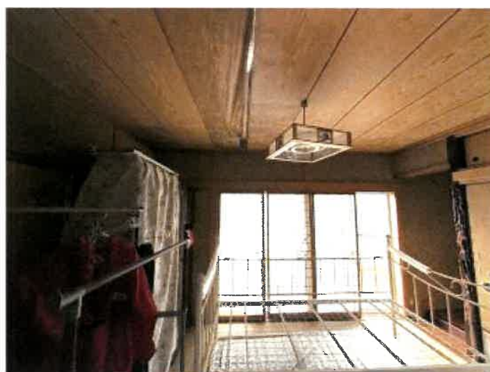
物件2 1階南西側和室の状況
