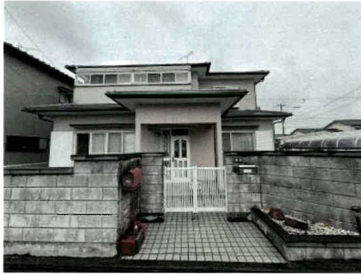
物件 2 南側の状況
