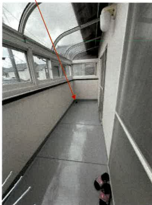
物件 2 2階南側サンルームの状況
