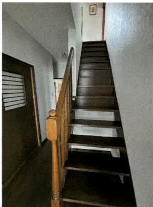
物件2 階段の状況
