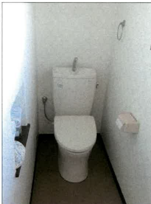
物件 2 建物の 2 階トイレの状況
