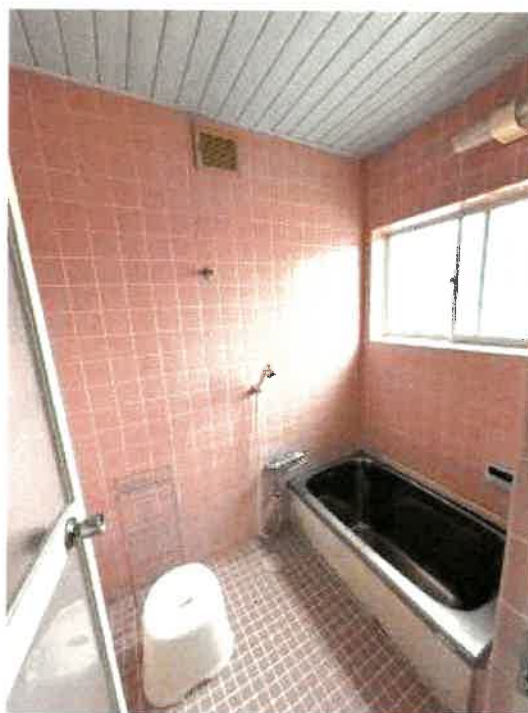
物件 2 1 階浴室の状況
