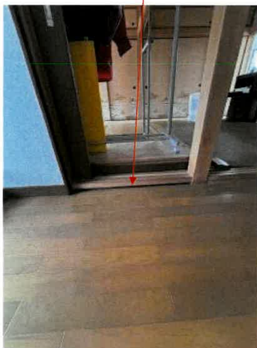
物件2 1階廊下の状況
