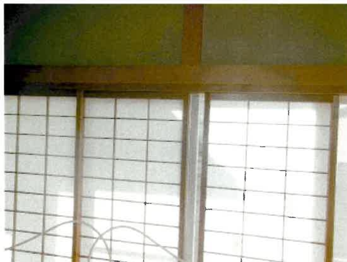
物件4建物の1階西側和室2間の鴨居中央付近が下がっている状況
