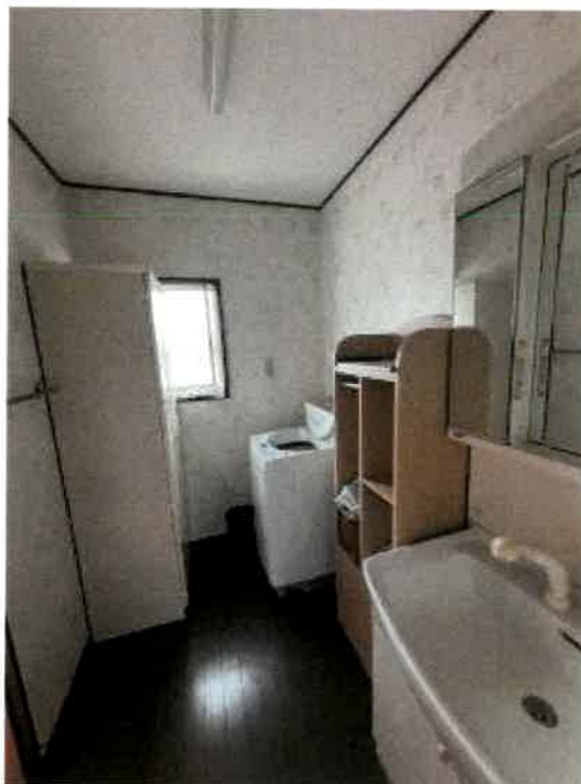
物件 2 1 階洗面脱衣所の状況
