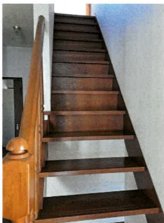
物件2建物の階段の状況
