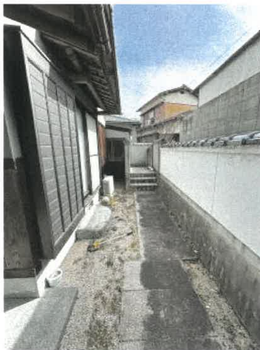
物件1 南側の状況
