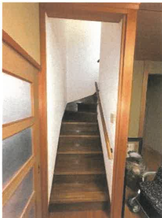
物件2 階段の状況
