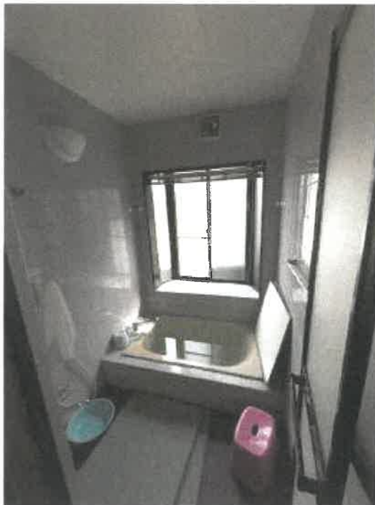
物件2 1階浴室の状況
