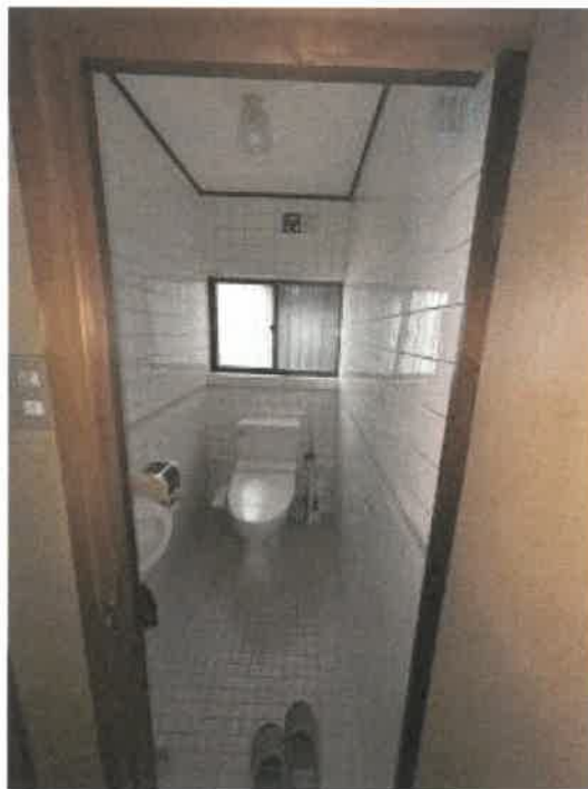
物件2 1階トイレの状況
