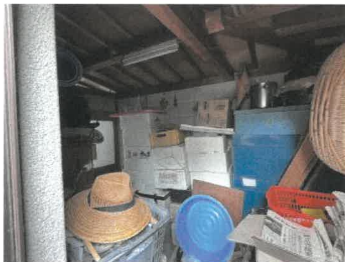
物件2 未登記増築部分（物置）の状況
