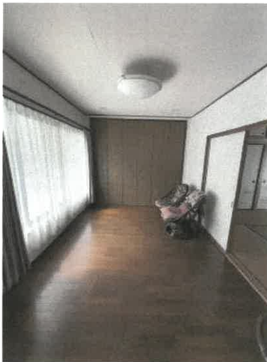
物件 2 2階南西側洋室の状況
