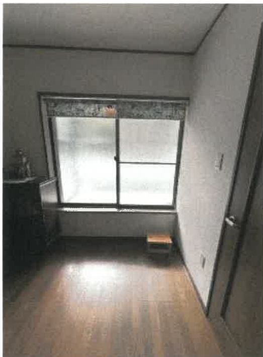
物件2 2階廊下（バルコニー入口）の状況
