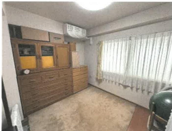
西側洋室の状況
