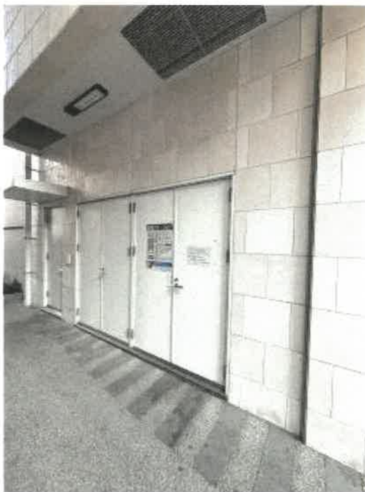
マンション住宅用ゴミ置場の状況
