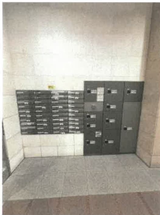
集合郵便受け、宅配ボックスの状況
