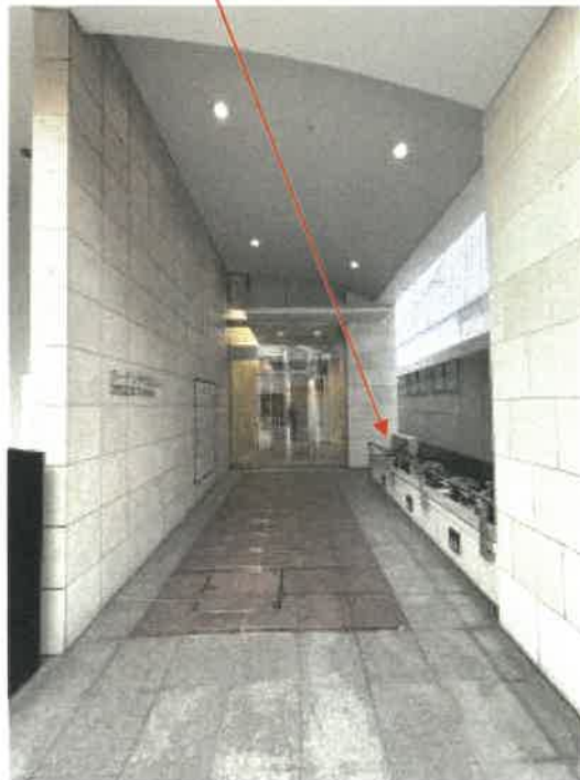
マンションスロープの状況
