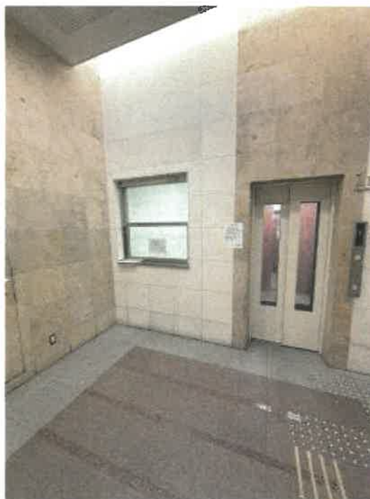
管理人室、エレベータの状況
