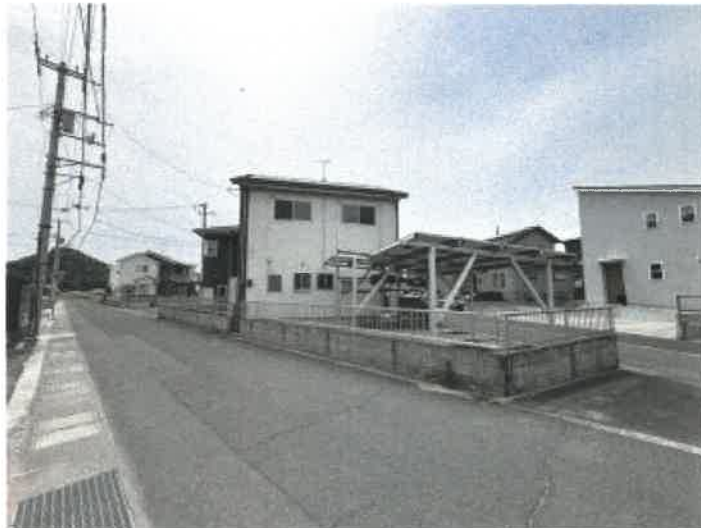
物件1 北西側の状況
