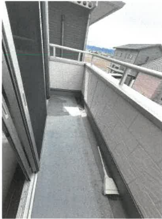
物件2 バルコニーの状況
