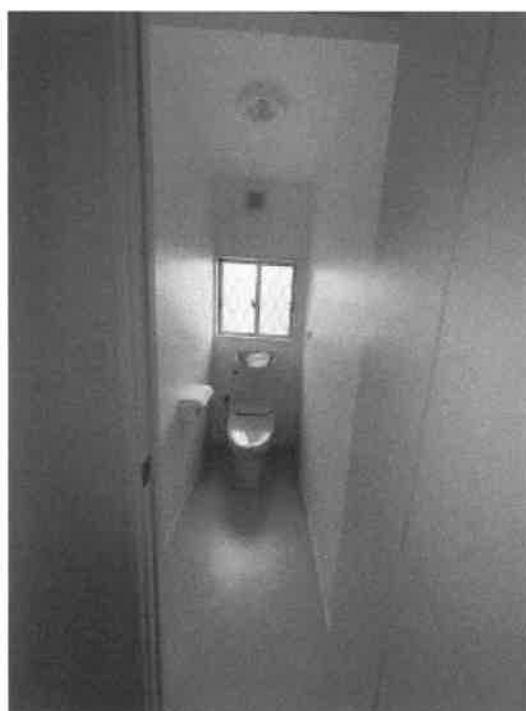
物件2 1階トイレの状況
