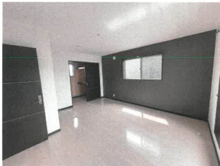
物件 2 2階東側洋室の状況
