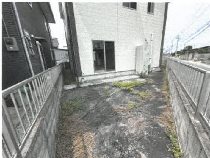
物件1 北東側の状況
