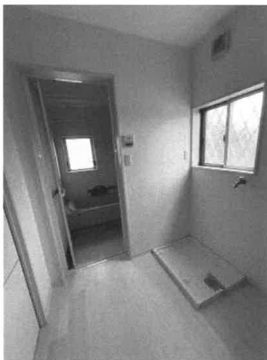
物件2 1階脱衣所の状況
