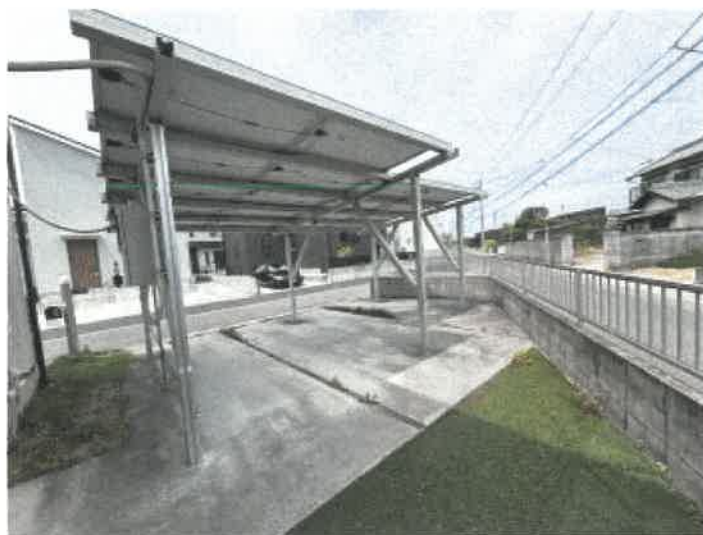
物件1 カーポートの状況
