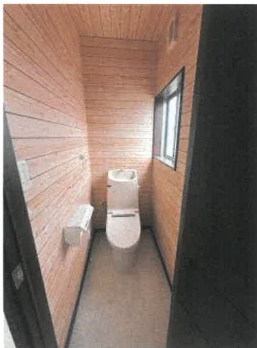
物件 2 2階トイレの状況
