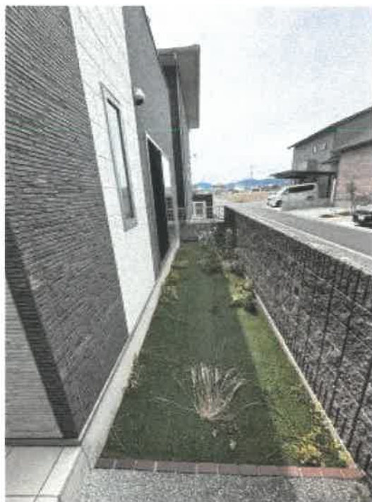
物件1 南側の状況
