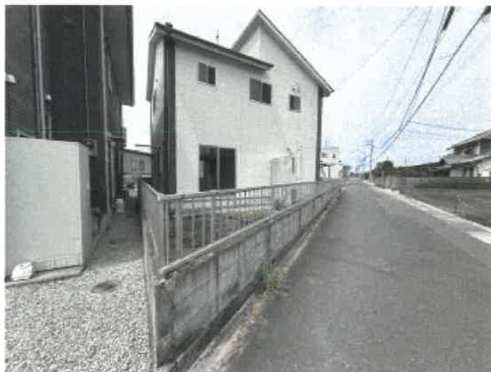
物件1 北東側の状況
