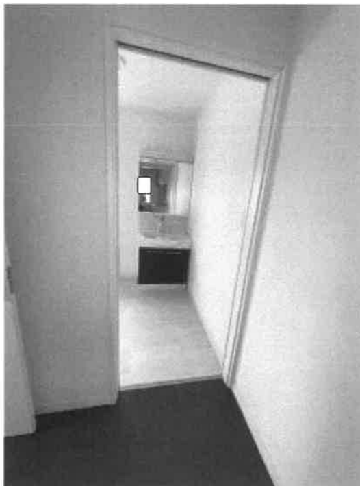
物件2 1階洗面所の状況
