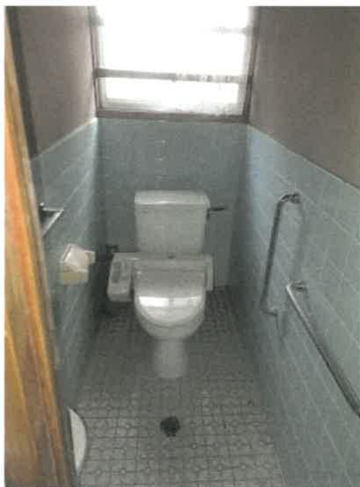
物件 2 建物の 1 階トイレの状況
