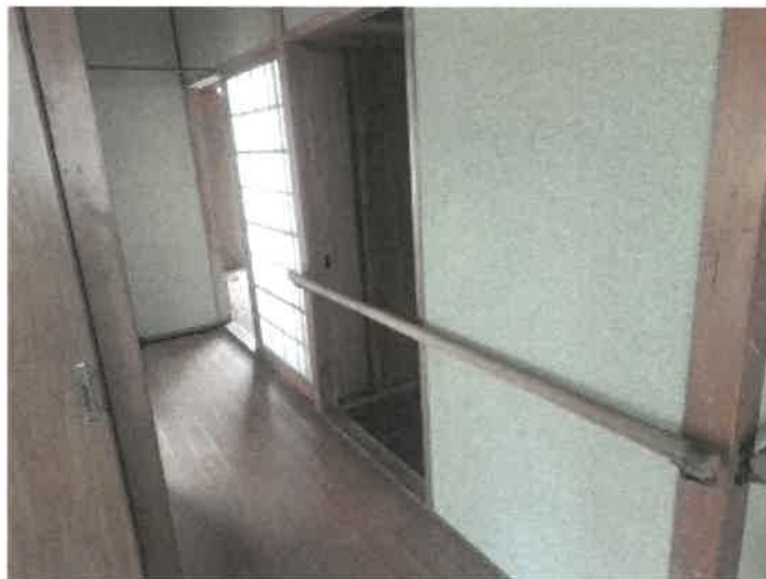
物件2建物の1階玄関前廊下の状況
