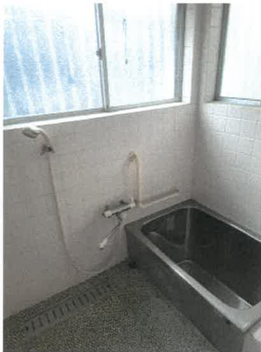
物件 2 建物の 1 階浴室の状況
