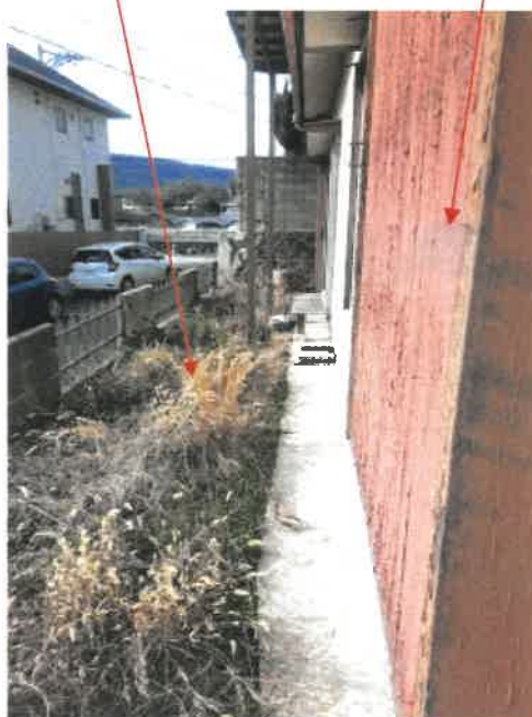
物件2建物南西側の状況
