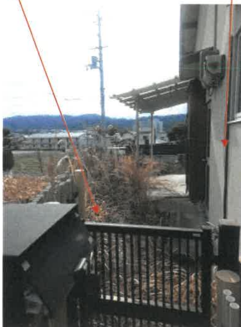
物件2建物南東側の状況
