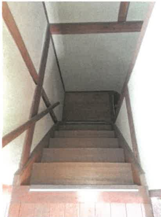
物件 2 建物の階段の状況
