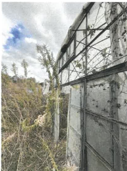
物件5 ハウス北西側の状況
