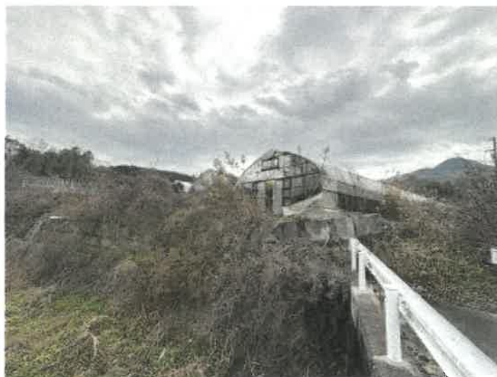
物件5 北西側の状況
