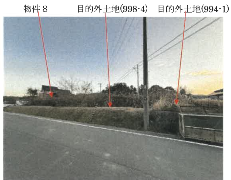
物件8 北東側の状況
