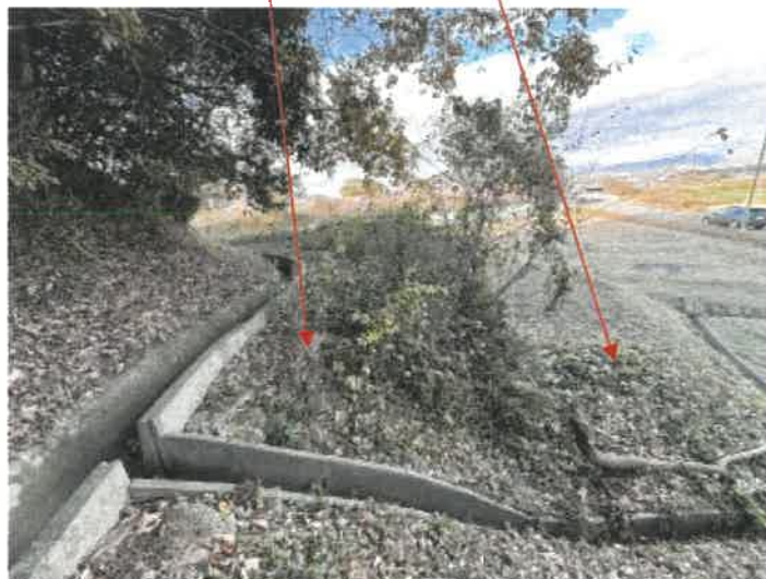
物件6 南東側の状況
