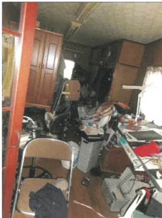
物件 2 建物の 1 階東端事務室の状況
