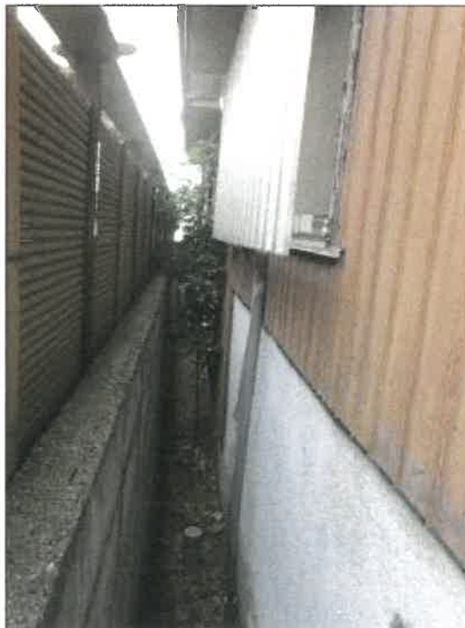
物件 2 建物北側の状況
