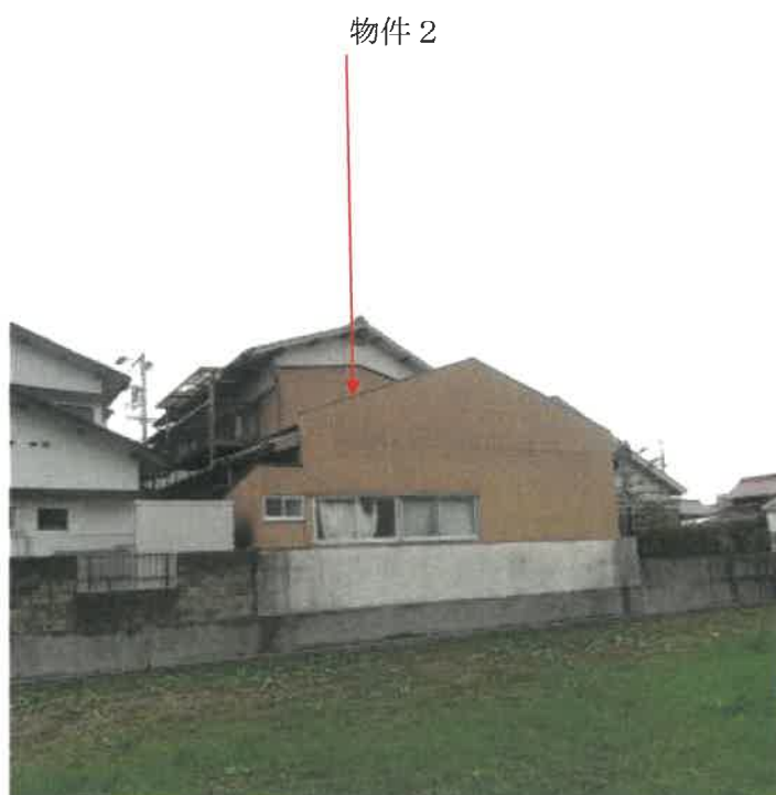
物件 2 建物東面の状況
