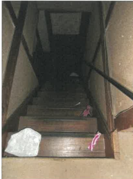
物件 2 建物の階段の状況
