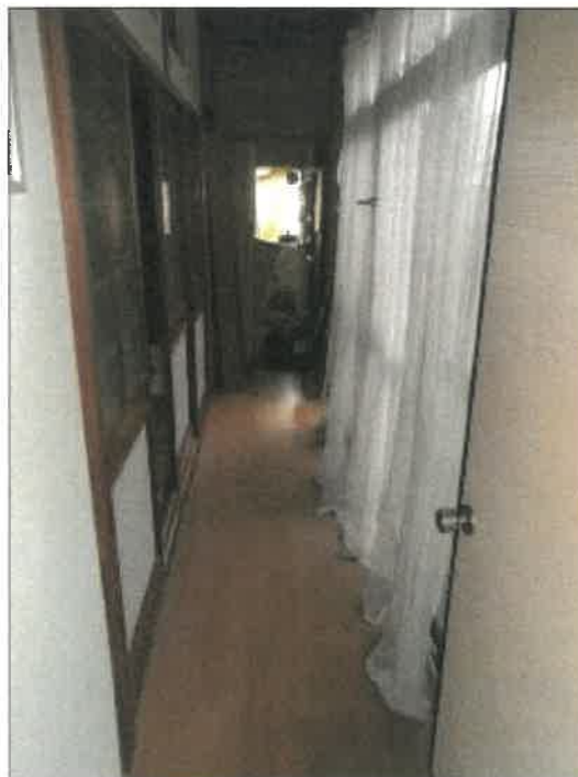
物件2建物の1階南側東西縁側の状況
