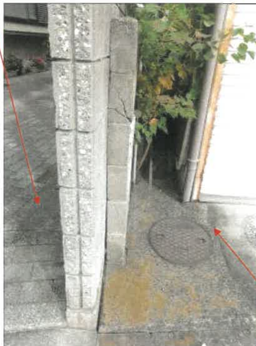
物件 1 土地北側境界付近の状況
