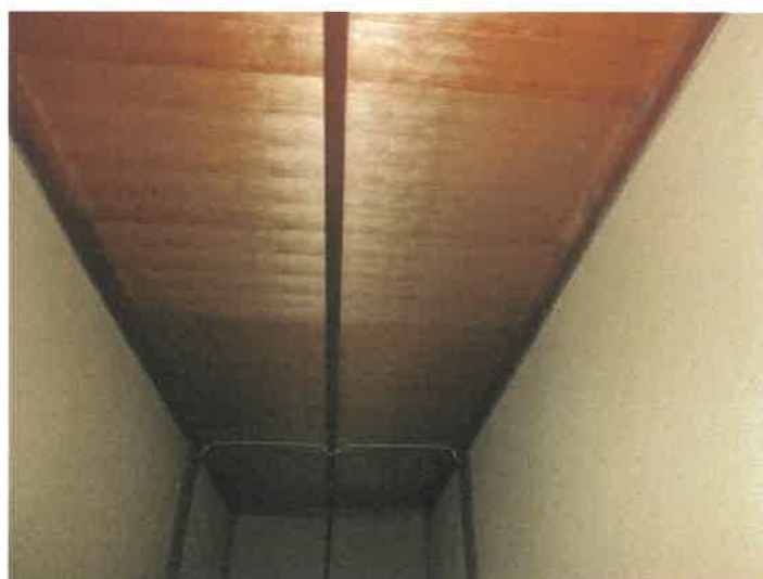
物件2建物の2階東側東西縁側の状況
