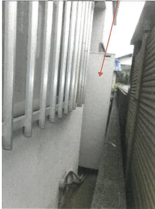
物件 2 建物北側の状況
