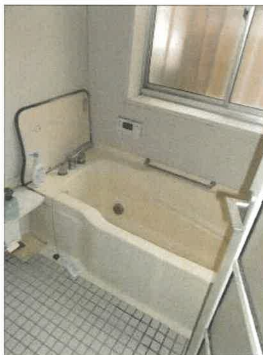
物件2建物の1階浴室の状況
