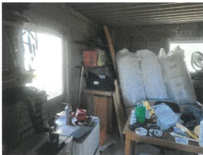
物件 2 附属建物符号 1 の内部の状況
