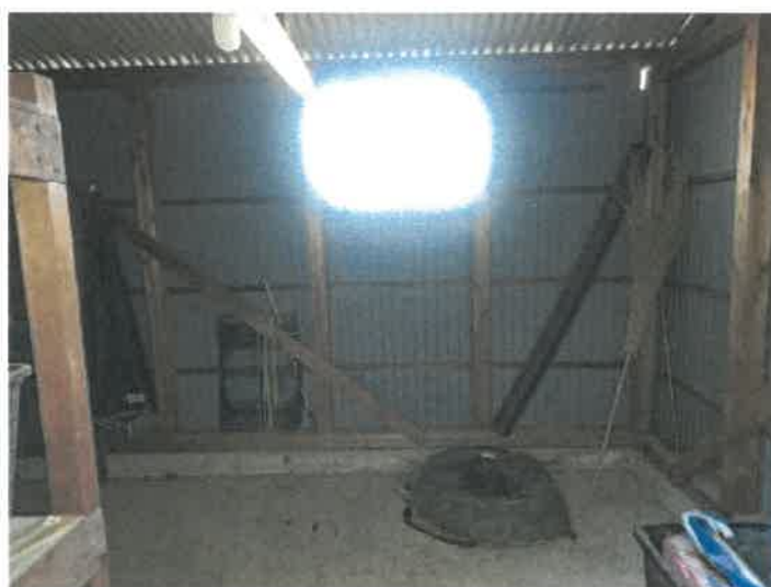
物件 2 未登記附属建物の内部の状況
