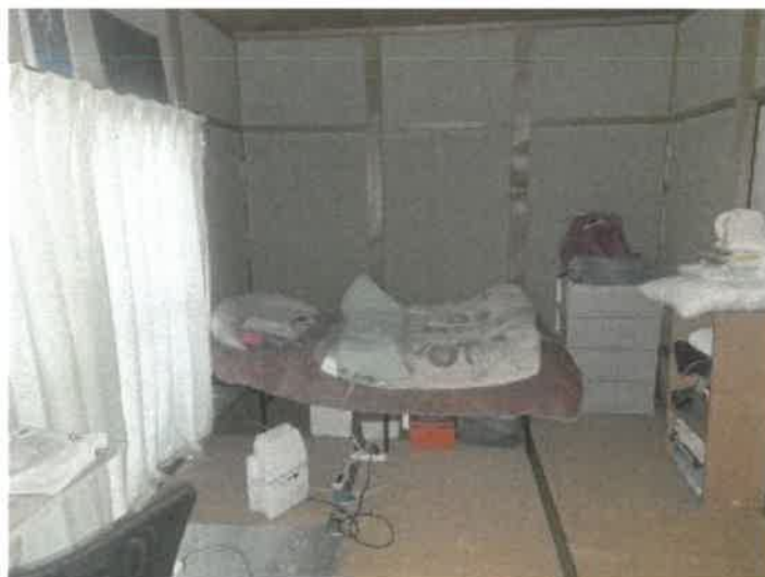
物件 2 主である建物の北ゾーンの 1 階西側南和室の状況
