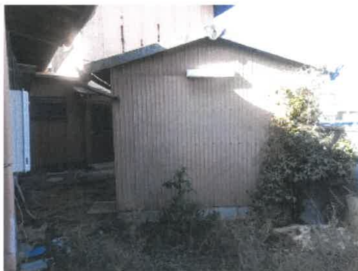
物件2未登記附属建物の状況
