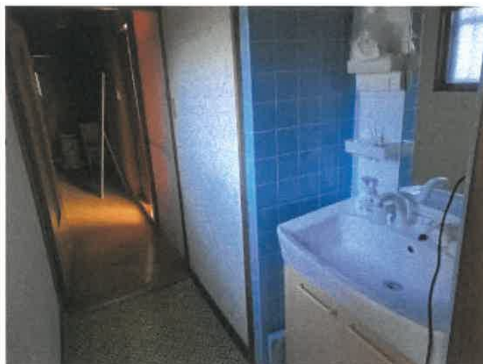
物件 2 主である建物の 1 階南ゾーンから北ゾーンへの廊下の状況
