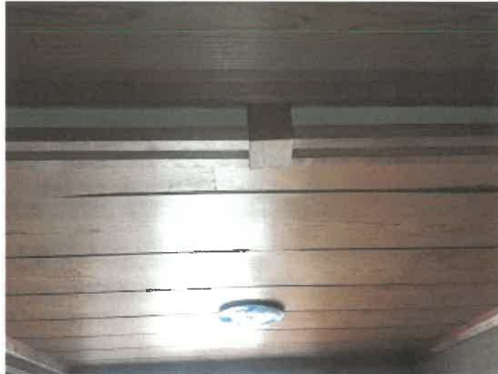
物件2主である建物の1階南ゾーン西端洋室の状況2間の間の鴨居を撤去している状況
