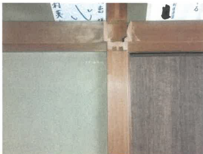
物件2主である建物の1階南ゾーン西端洋室の状況2間の間の鴨居を撤去している状況
