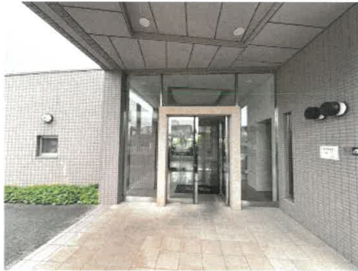
マンション入口付近の状況
