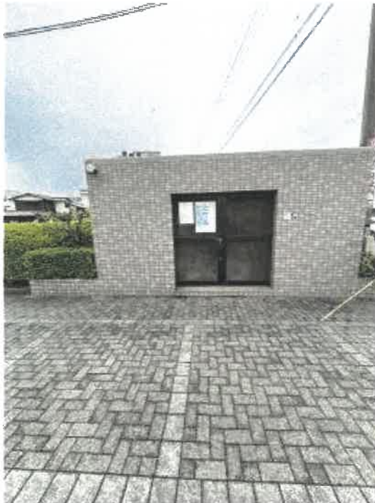
ゴミ置場の状況
