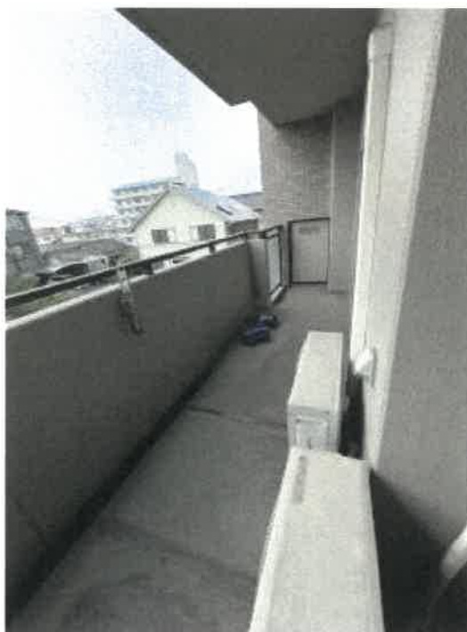
バルコニーの状況
