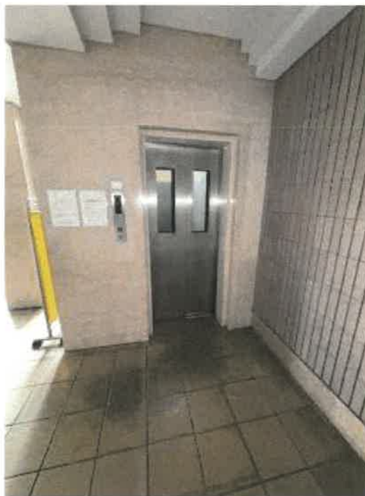
エレベーターの状況
