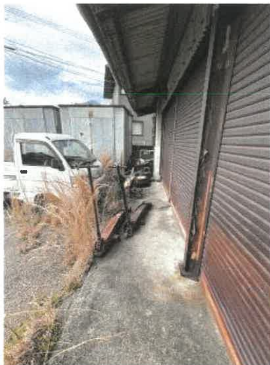
物件2 南西側の状況
