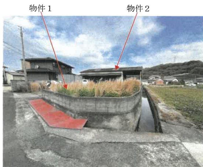
物件 1 南西側の状況
