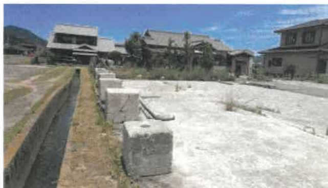
物件 1、3 及び 7 土地西側の状況
