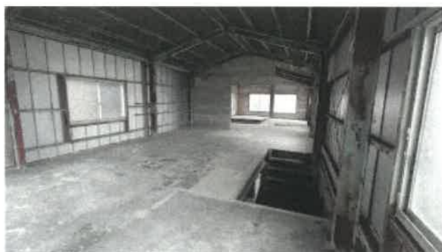
物件 1 1 附属建物 2 階倉庫内の状況
