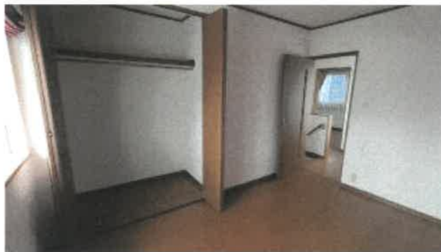
物件 1 1 主である建物 2 階南西側洋室の状況
