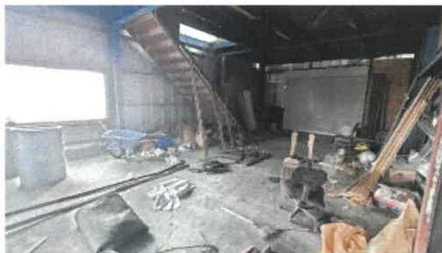
物件11附属建物1階倉庫内の状況
