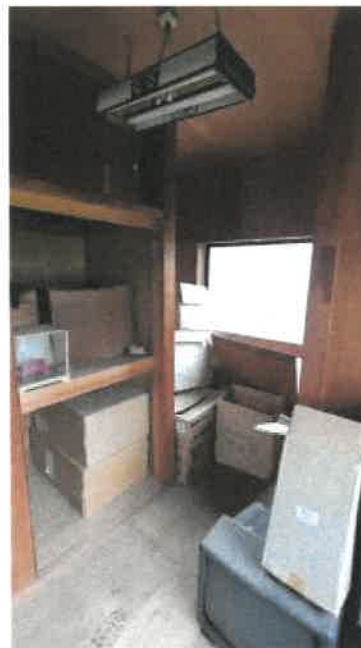
物件12附属建物板敷の状況
