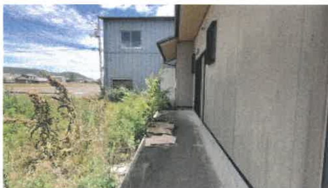
物件 4 及び 5 土地北側の状況
