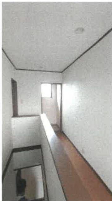
物件1 1主である建物2階廊下の状況
