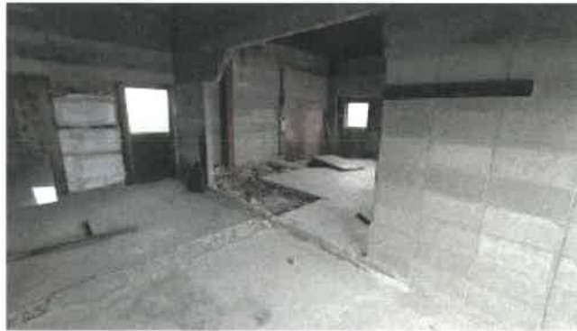
物件 1 1 附属建物 1 階倉庫内の状況
