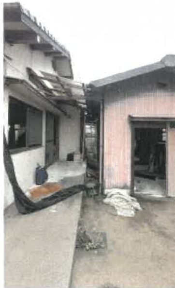
物件1 2主である建物入口・スロープの状況
