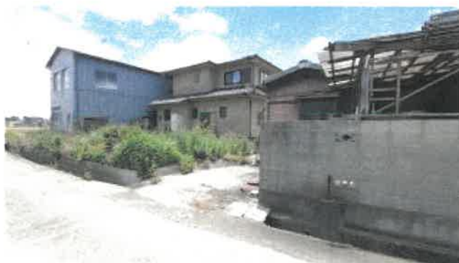
物件 5 及び 7 土地北側の状況
