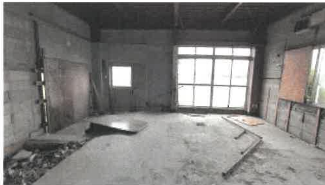
物件 1 1 附属建物 1 階倉庫内の状況
