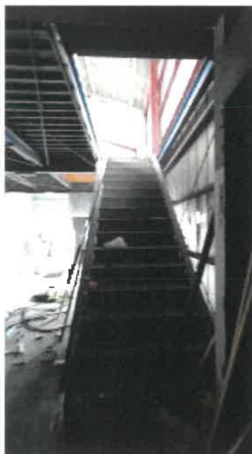
物件 1 1 附属建物 1 階階段の状況
