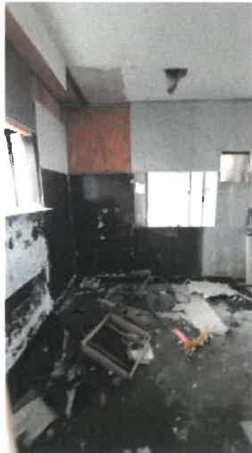
物件 1 2 主である建物厨房跡の状況
