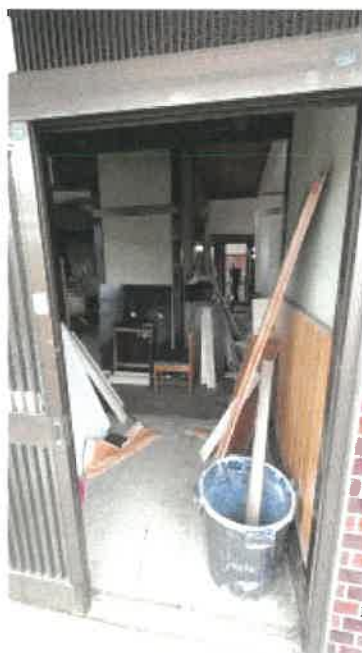
物件12主である建物玄関内の状況
