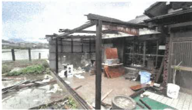
物件 1 2 主である建物下屋の状況
