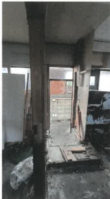
物件1 2主である建物厨房跡の状況
