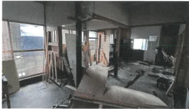
物件1 2主である建物コンクリート土間の状況
