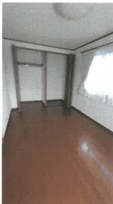
物件 1 1 主である建物 2 階東側洋室の状況
