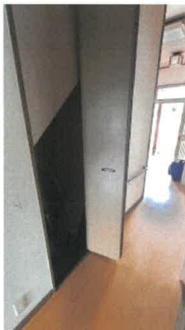
物件 1 1 主である建物廊下側物入の状況
