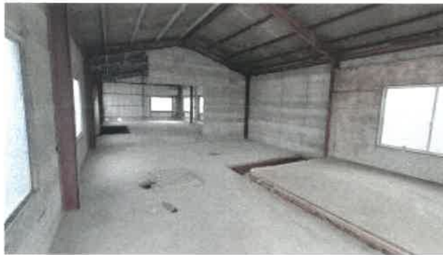
物件 1 1 附属建物 2 階倉庫内の状況
