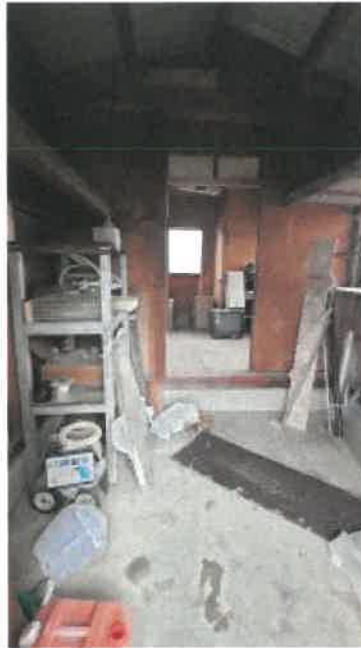
物件12附属建物コンクリート土間の状況
