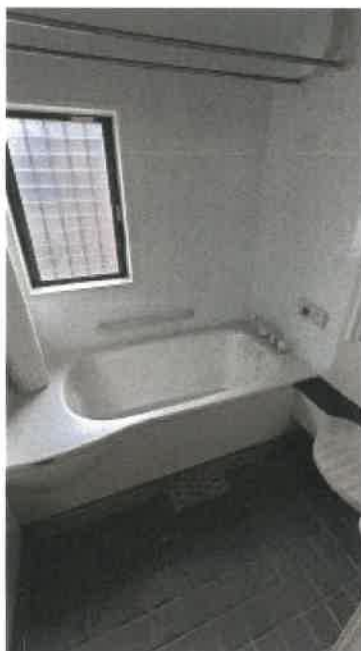
物件11主である建物浴室の状況
