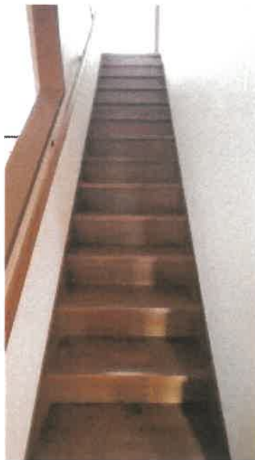
物件 1 1 主である建物階段の状況
