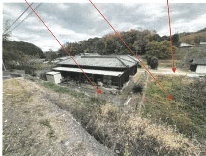
物件 1 南西側の状況
