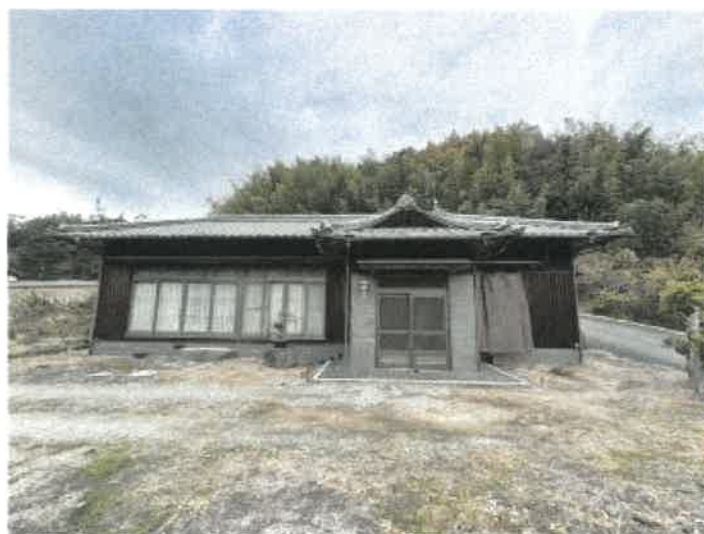
物件 2 東側の状況
