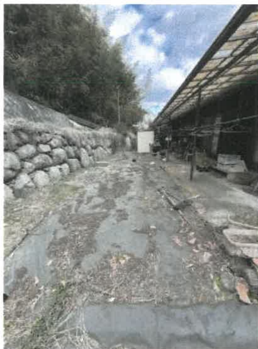
物件1 南西側の状況
