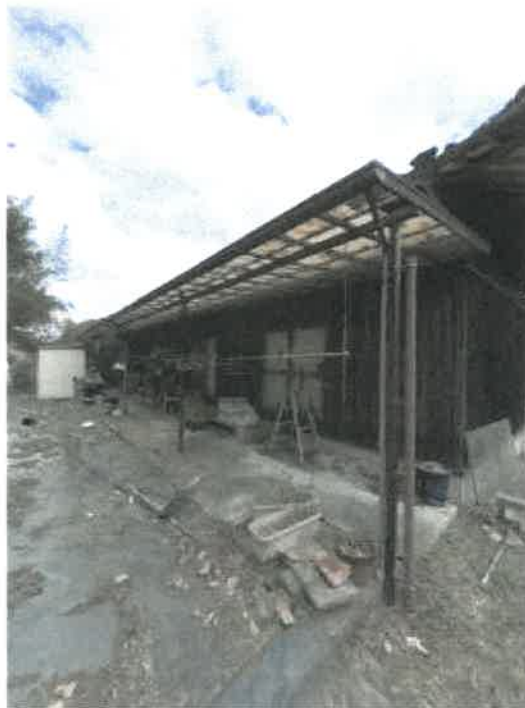
物件 2 南西側の状況
