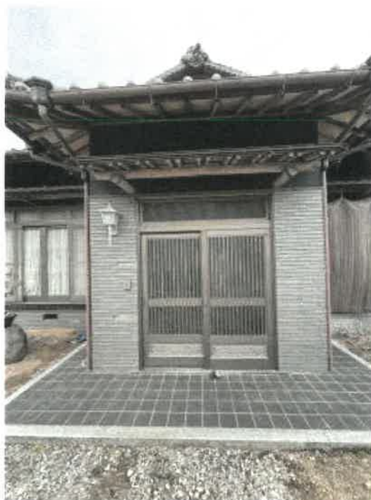
物件 2 玄関の状況
