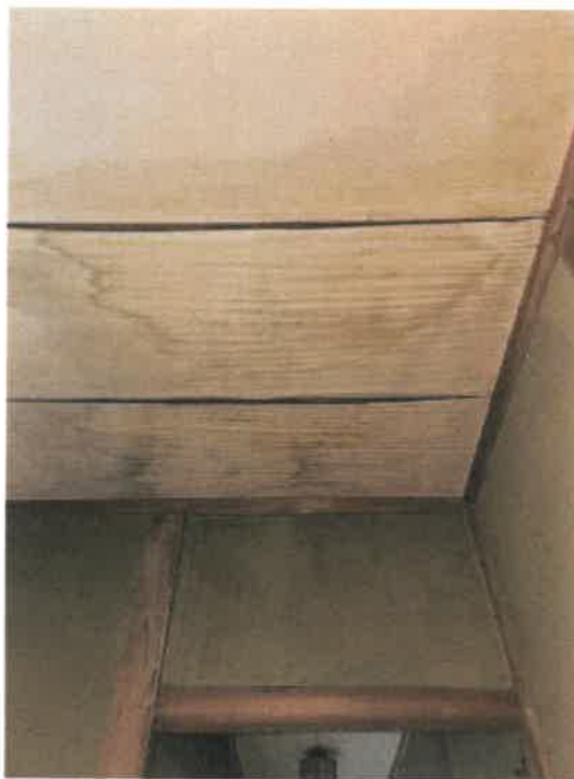
物件2 北西側廊下天井の状況
