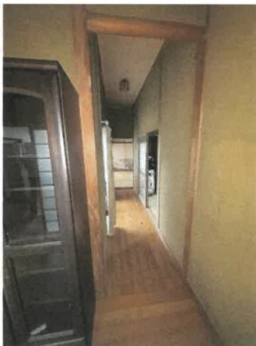
物件2 北西側廊下の状況
