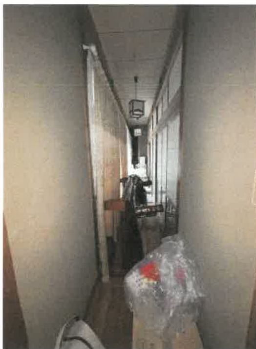
物件 2 南東側廊下の状況
