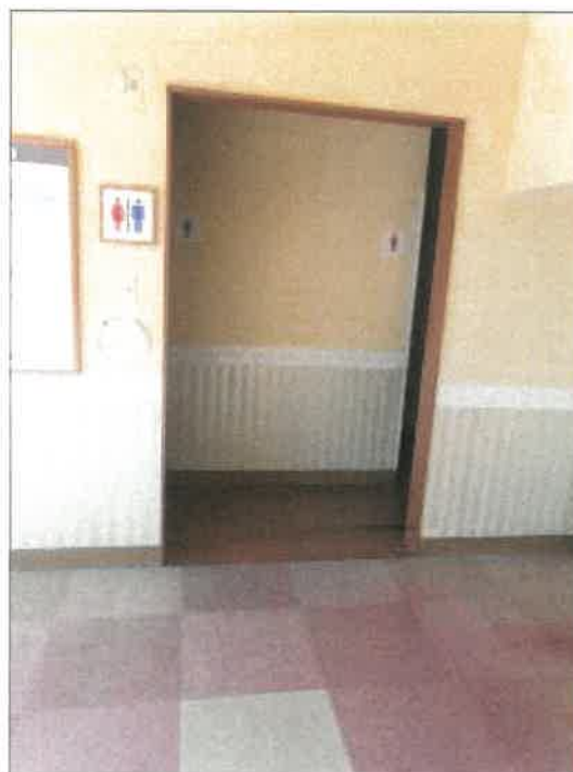
受付付近トイレ出入口付近の状況
