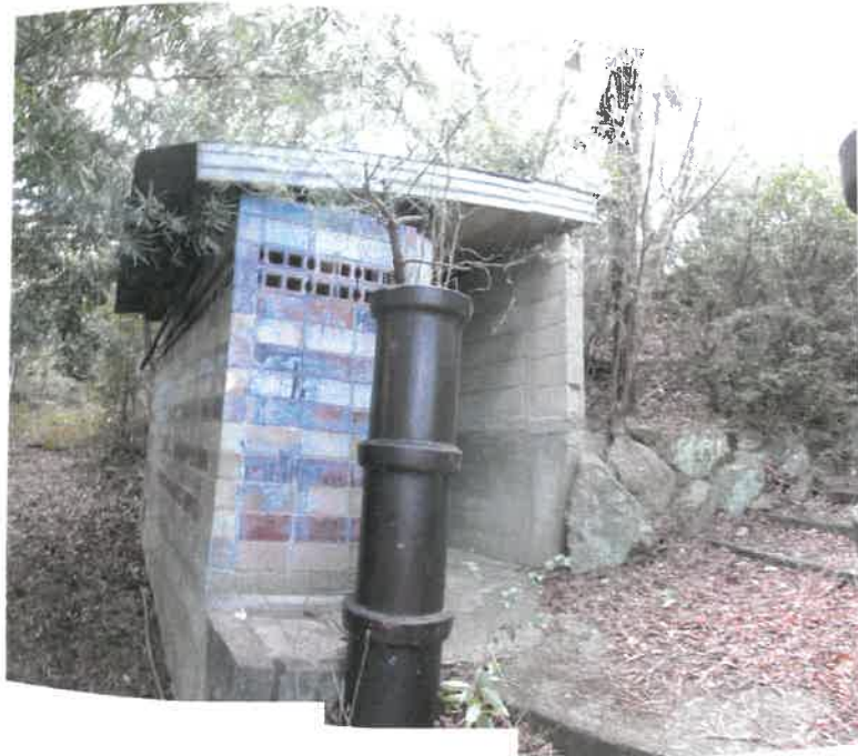
物件 3 5 未登記附属建物E の状況
