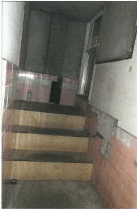
物件 3 5 建物増築部分 B の 2 階客室階の南西側出入口付近の状況
