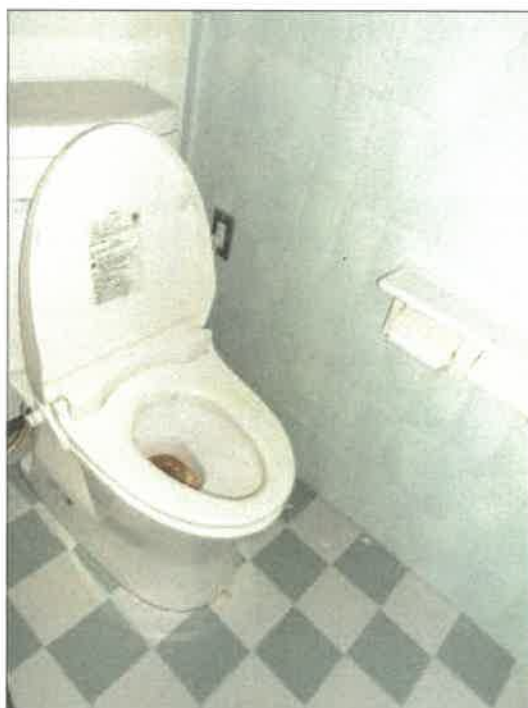
物件35建物の2階男子トイレの状況
