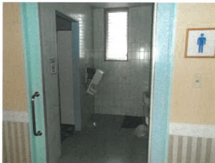
物件 3 5 建物の 2 階男子トイレの状況
