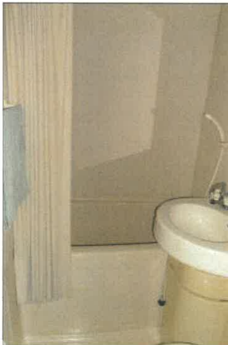
物件 3 2 部分 3 階客室⑤の状況
