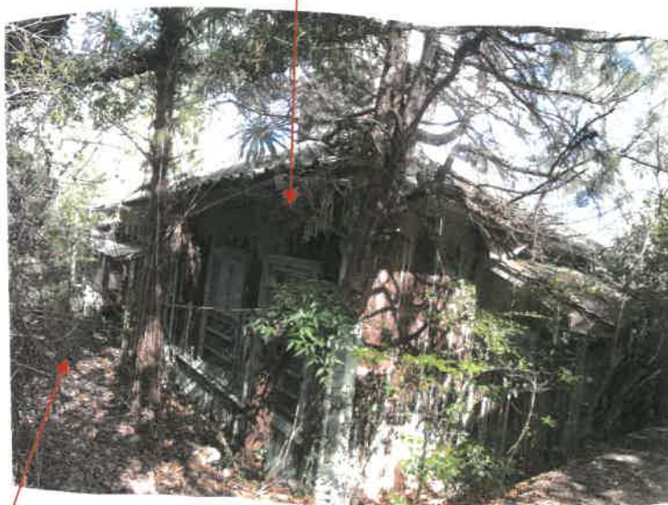
物件 3 5 未登記附属建物 C の南面及び西面の状況
