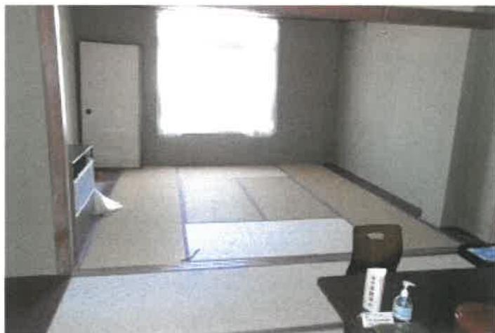
物件 3 2 部分 3 階客室⑦の状況
