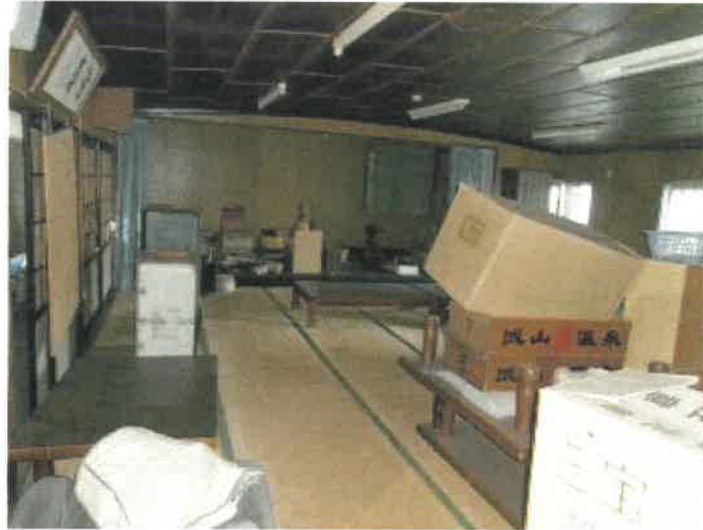
物件3 1部分の2階広間（宴会場）の状況
