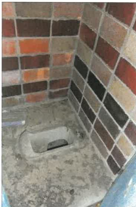
物件35未登記附属建物Eの状況
