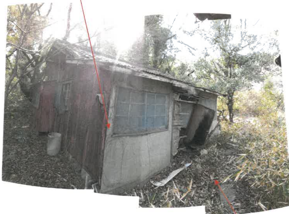
物件 3 0 主である建物の状況
