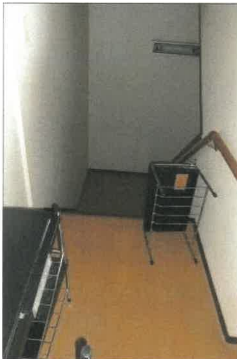
物件3 2部分2階から1階への階段の状況
