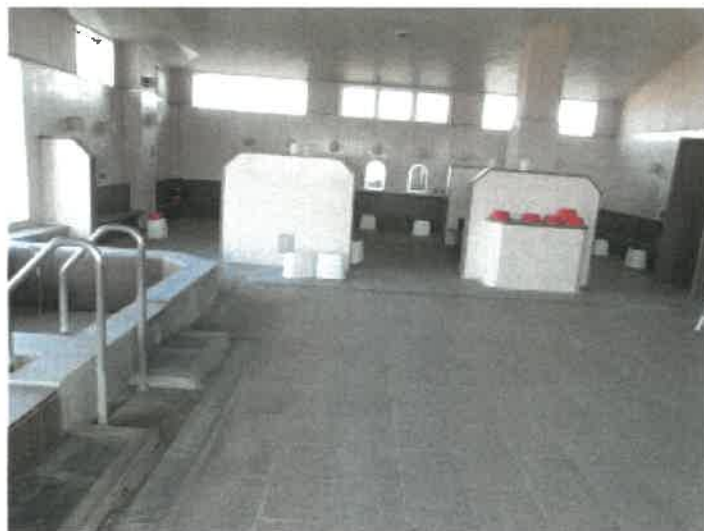
物件 3 5 建物 3 階の女性用洗室の状況
