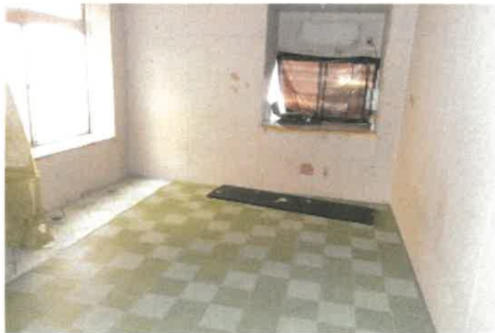
物件 3 5 建物増築部分 A 1 階（役者用宿泊ゾーンの宿泊部屋①）の状況
