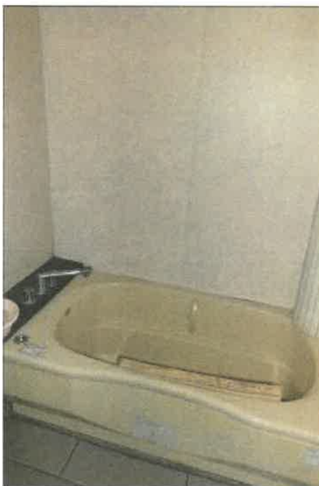
物件3 1部分の1階浴室の状況
