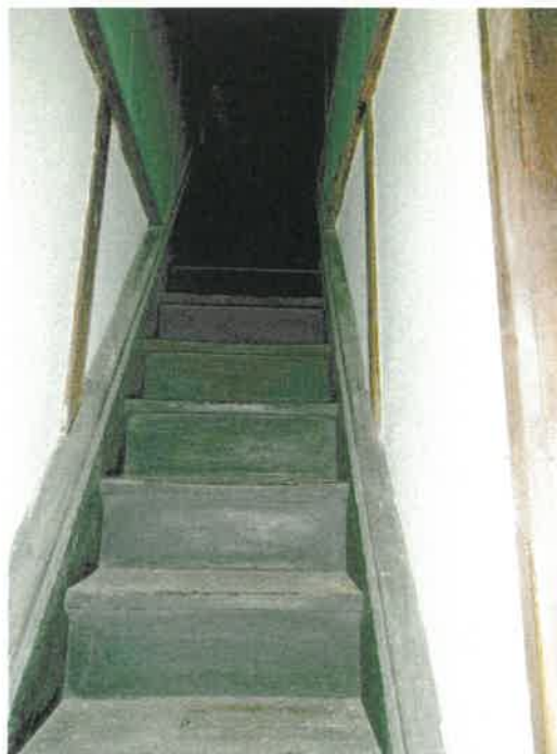
物件 3 5 未登記附属建物 C の 2 階から 3 階への階段の状況
