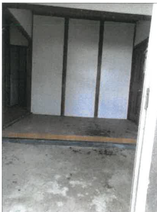
物件 3 5 未登記附属建物C 2 階玄関ホールの状況
