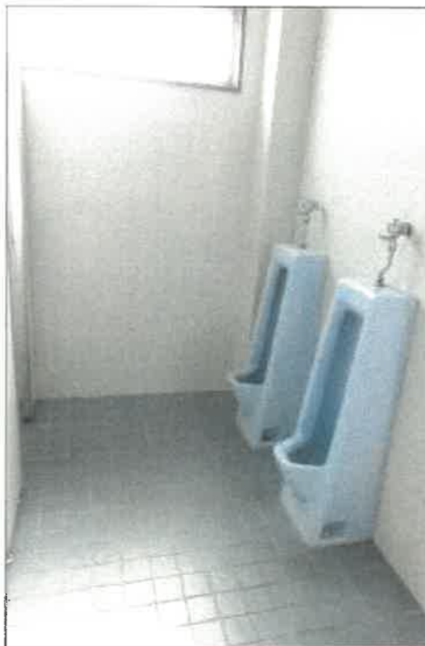
物件 3 2 部分 2 階男子トイレの状況
