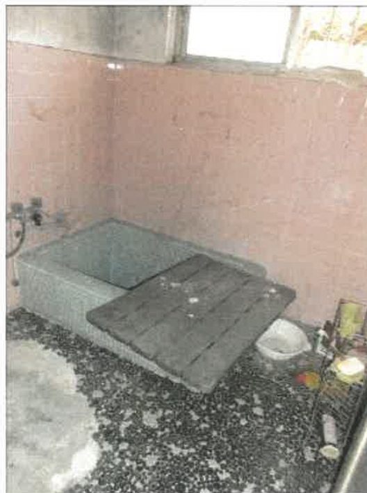
物件 3 4 建物の 1 階浴室の状況
