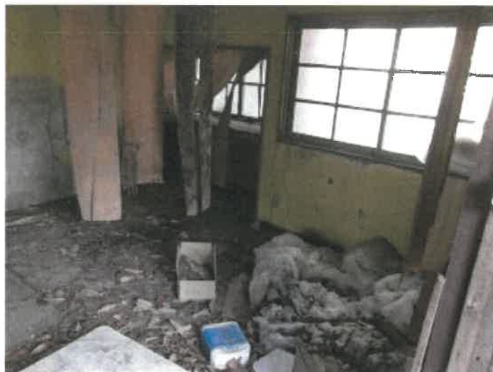
物件30主である建物の内部の状況
