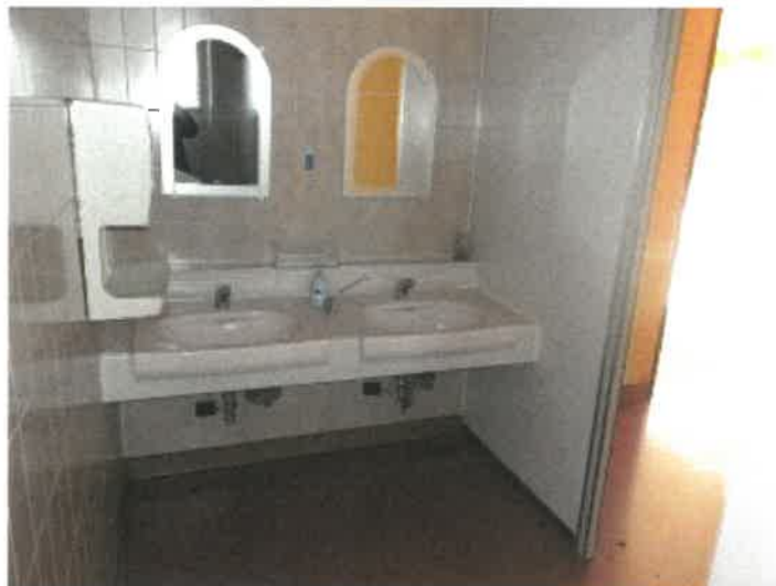
女性トイレの手洗場の状況
