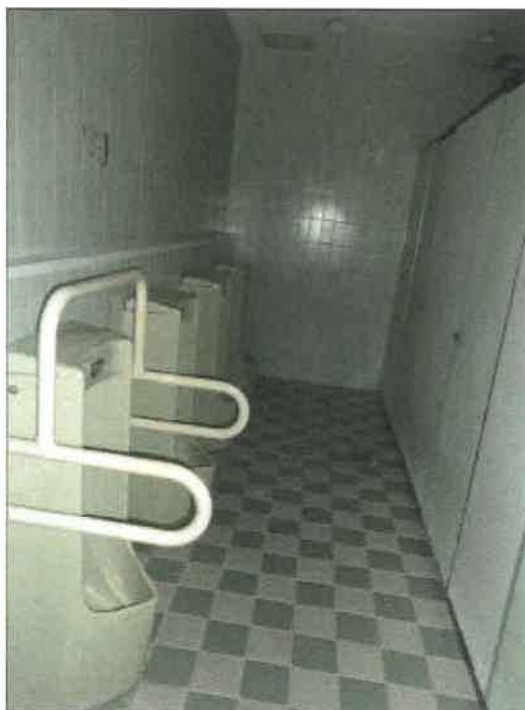
物件 3 5 建物の 2 階男子トイレの状況
