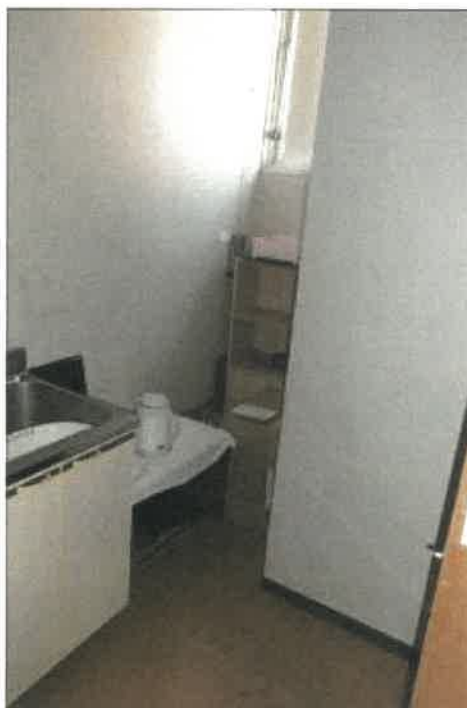
物件 3 2 部分 2 階配膳室の状況
