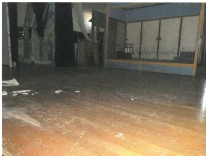
物件 3 5 建物増築部分 A 2 階（演劇場のステージ）の状況
