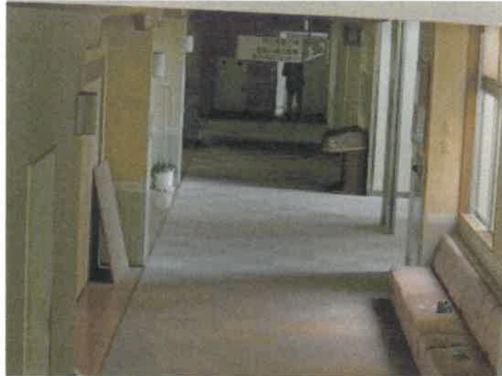
物件 3 5 建物の 2 階廊下の状況
