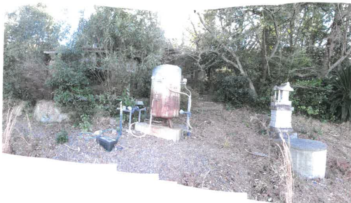
温泉源泉（2度目の掘削）周辺の状況
