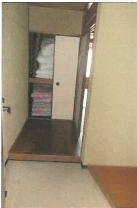
物件 3 2 部分 2 階客室③の状況
