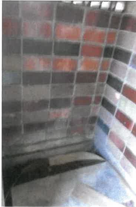
物件35未登記附属建物Eの状況
