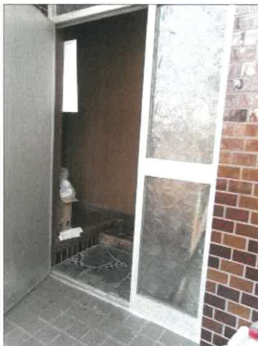
物件34建物の玄関付近の状況
