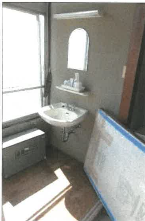
物件 3 2 部分 3 階客室⑨状況
