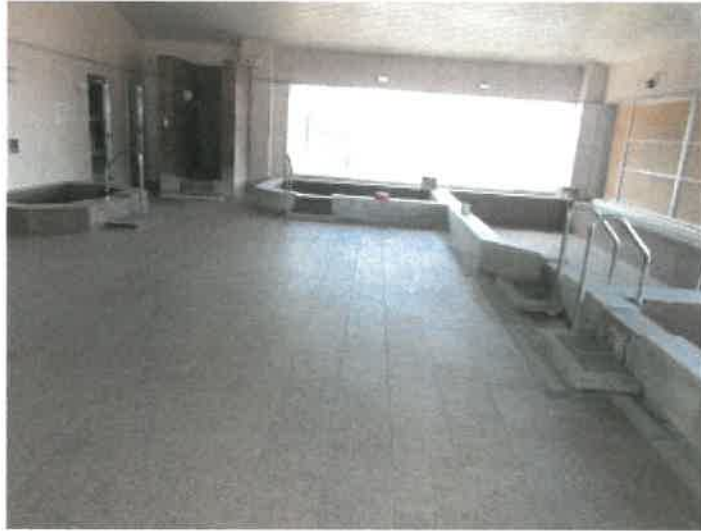
物件 3 5 建物 3 階の女性用洗室の状況
