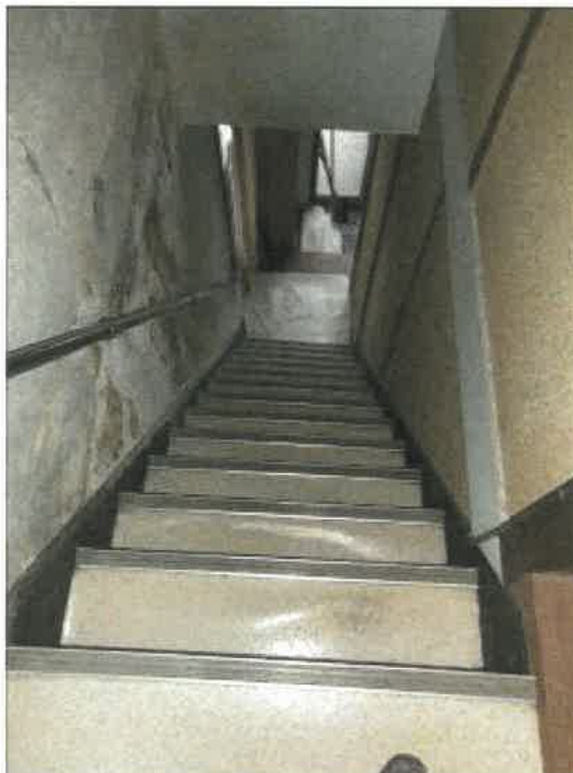
物件34建物の階段の状況
