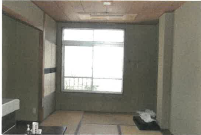
物件 3 2 部分 2 階客室④の状況
