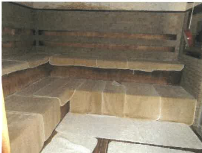
物件 3 5 建物 3 階の女性用サウナの状況
