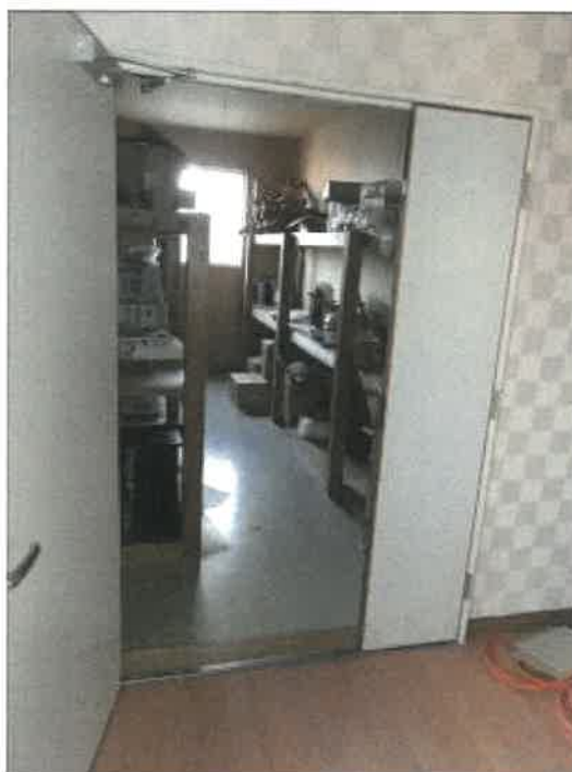
物件 3 5 建物の 2 階大広間北東側のステージ横の倉庫の状況
