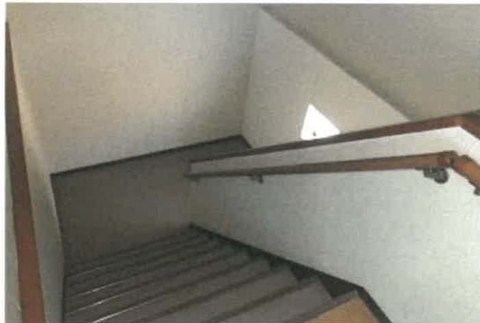
物件 3 2 部分 3 階から 2 階への階段の状況
