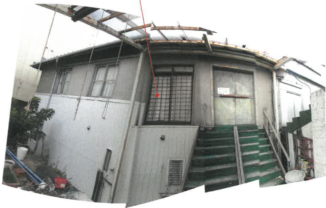
物件 3 1 部分の 2 階広間（宴会場）への出入口付近の状況
