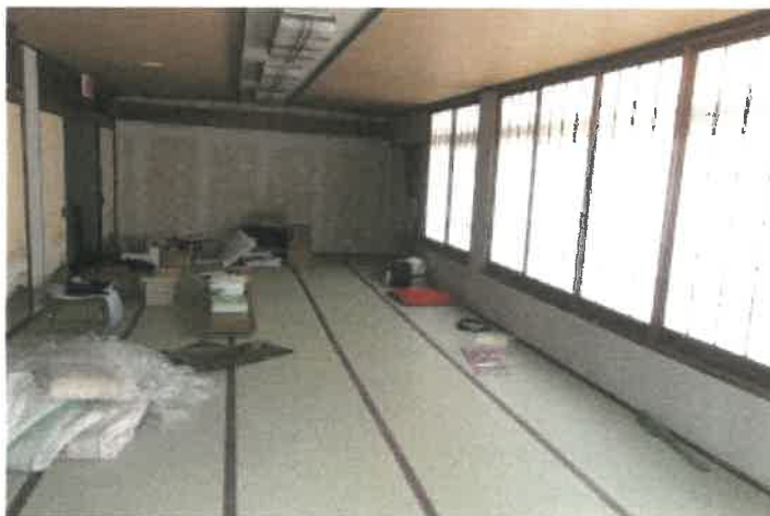
物件 3 2 部分 1 階広間の状況
