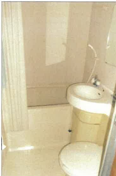
物件 3 2 部分 2 階客室③の状況
