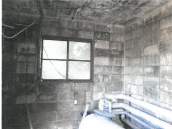
未登記附属建物 F （旧ボイラー室）の状況
