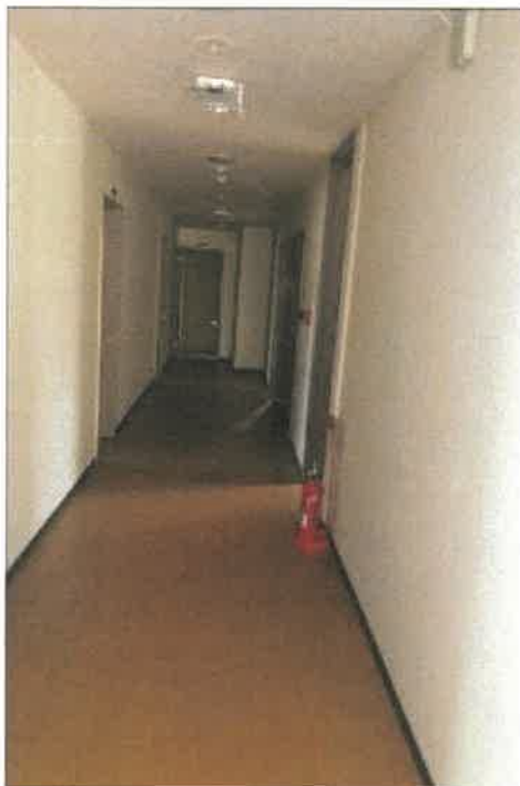
物件 3 2 部分 3 階の廊下の状況
