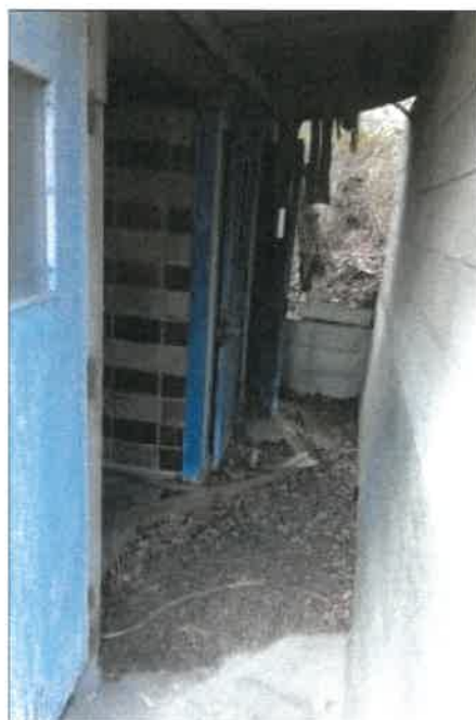
物件 3 5 未登記附属建物E の状況
