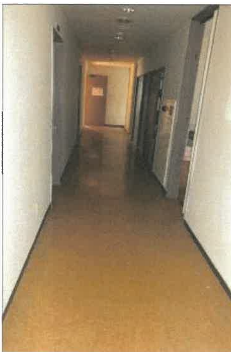
物件3 2部分2階廊下の状況
