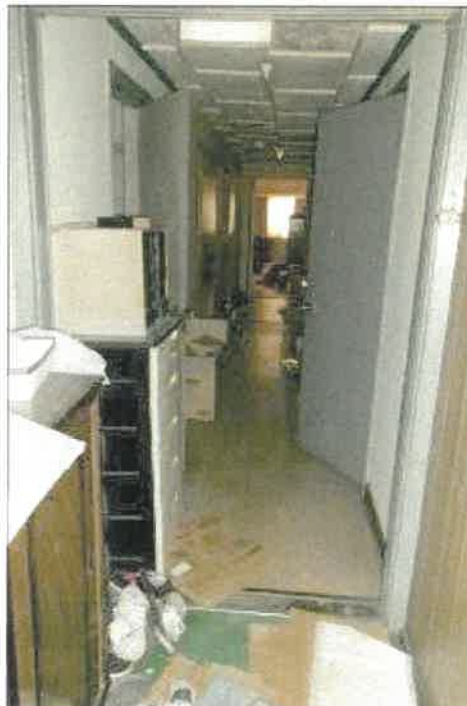
物件31部分の1階居室のトイレ前廊下の状況
