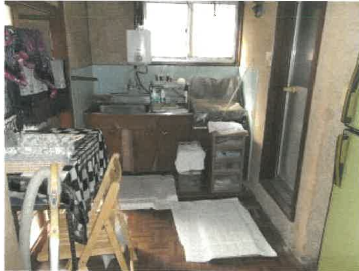
物件 3 4 建物の 1 階台所の状況
