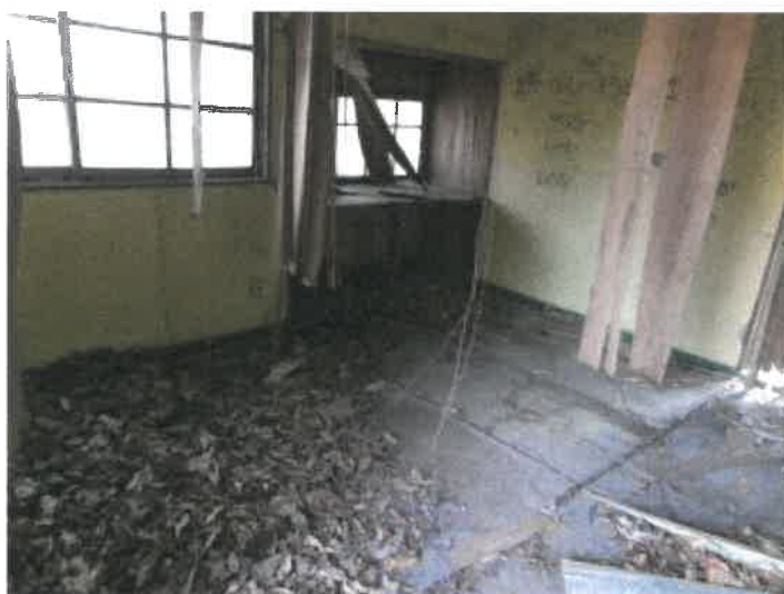
物件30主である建物の内部の状況
