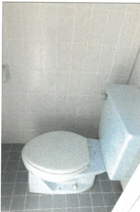
物件 3 2 部分 1 階男子トイレの状況
