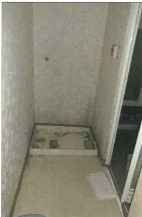
物件3 1部分の1階洗面脱衣所の状況
