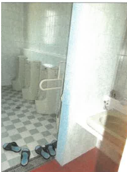
男子トイレ内の状況
