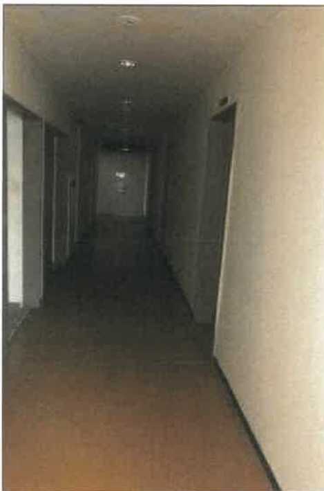
物件 3 2 部分 3 階の廊下の状況
