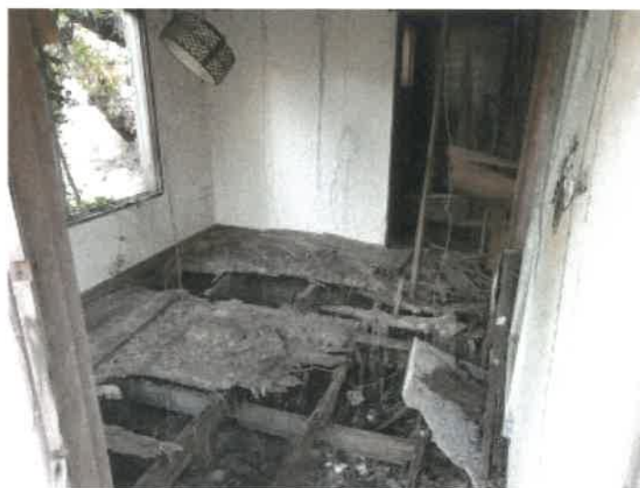
物件 3 0 附属建物符号 2 内部の状況
