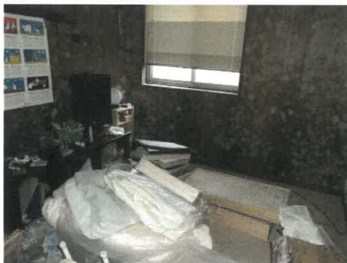
物件 3 4 建物の 1 階南西角和室の状況
