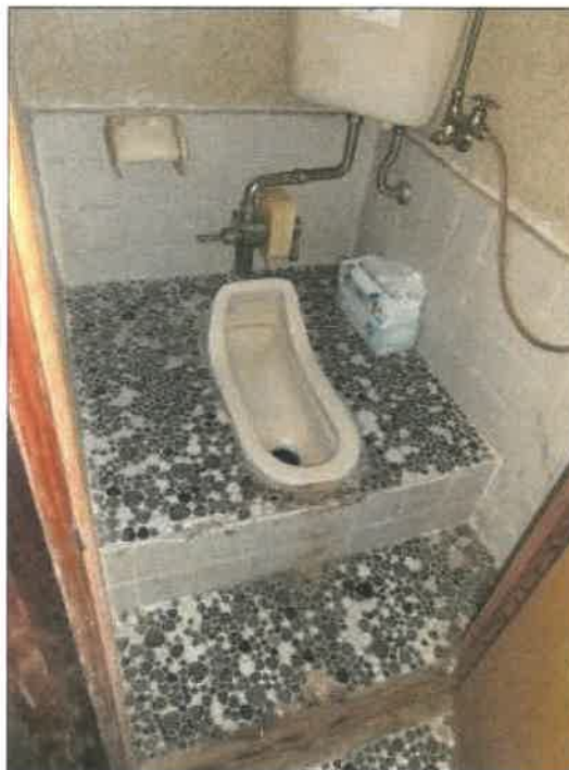
物件34建物の1階トイレの状況
