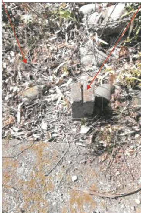
物件 2 9 土地北東角付近の境界石柱の状況
