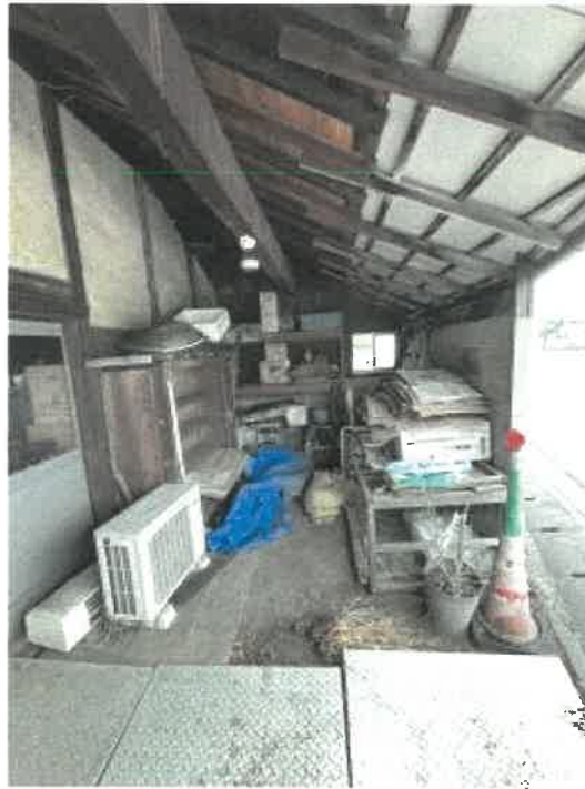
物件1 北東側の状況
