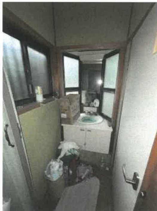
物件 2 手洗の状況
