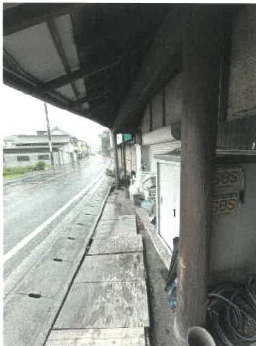
物件1 東側の状況
