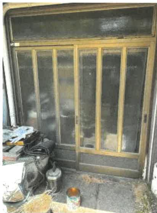
物件2 玄関の状況
