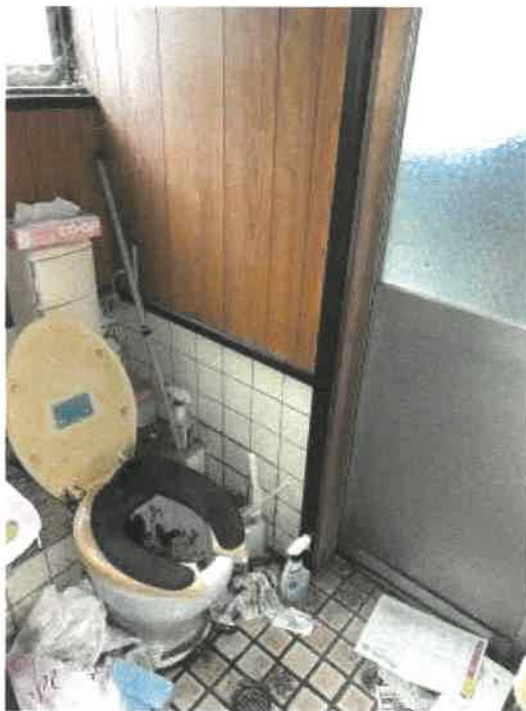
物件2 トイレの状況
