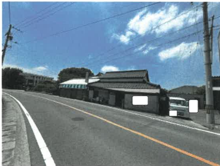
物件 1 北東側の状況
