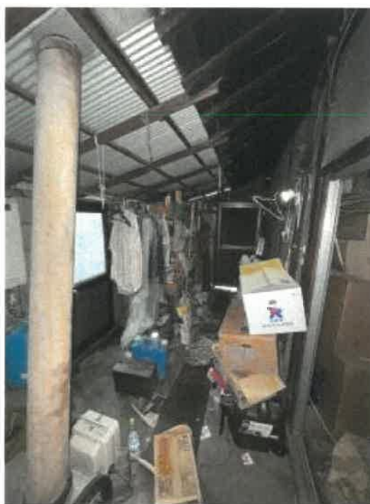
物件2 北側ホール（土間）の状況
