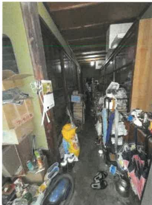
物件2 南側ホール（土間）の状況
