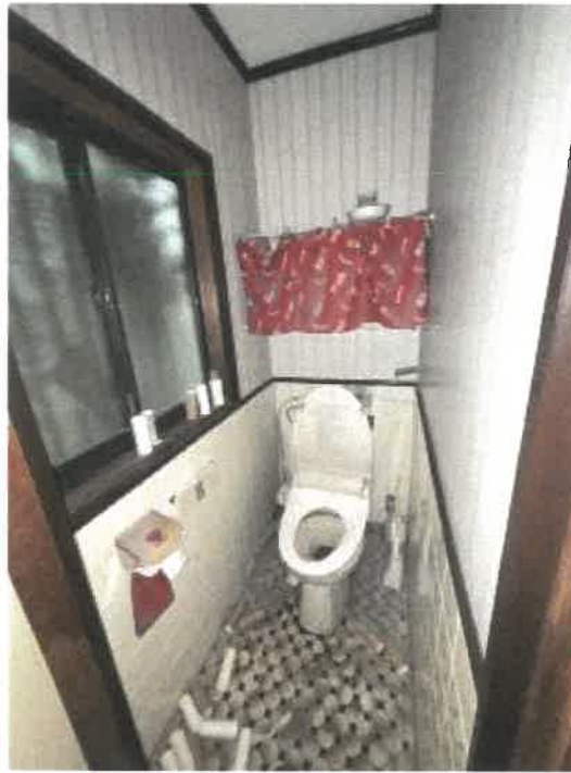
物件2 トイレの状況
