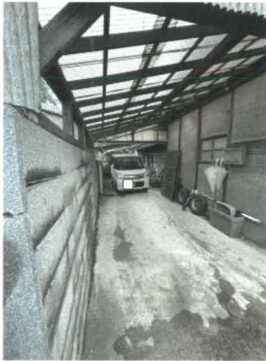
物件1 南東側下屋の状況
