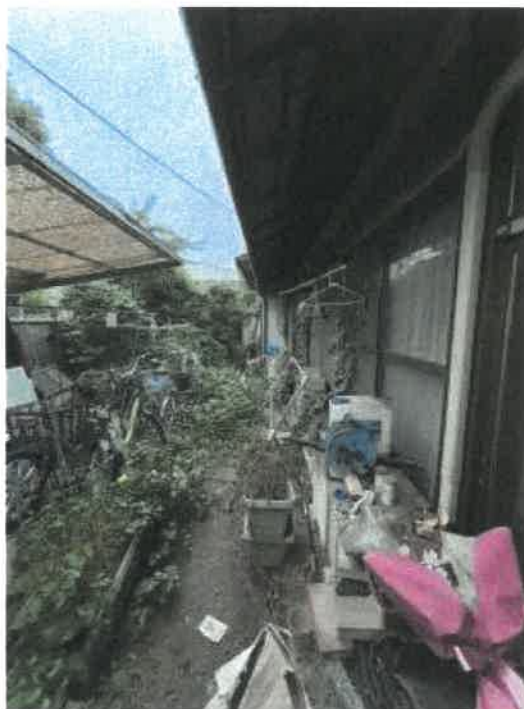
物件1 南側の状況
