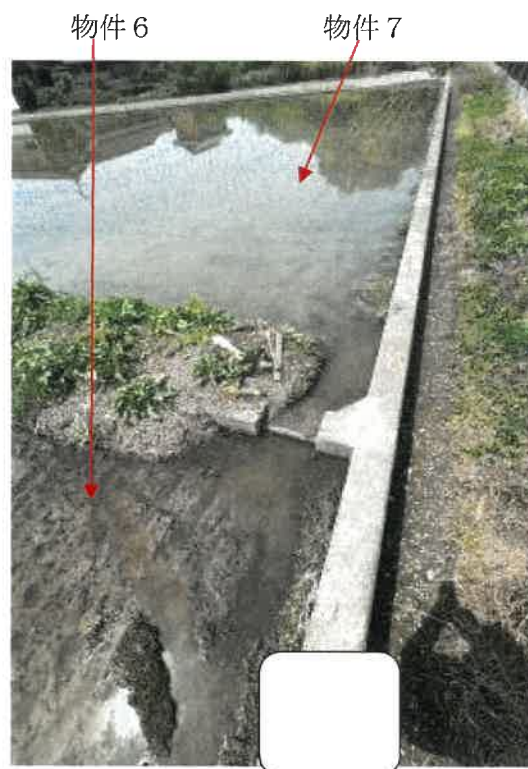
物件 6、7 北側境界付近の状況
