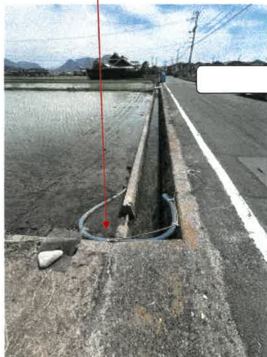
物件7 南西側の状況
