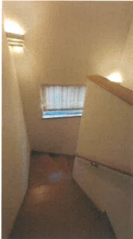
物件 2 階段の状況
