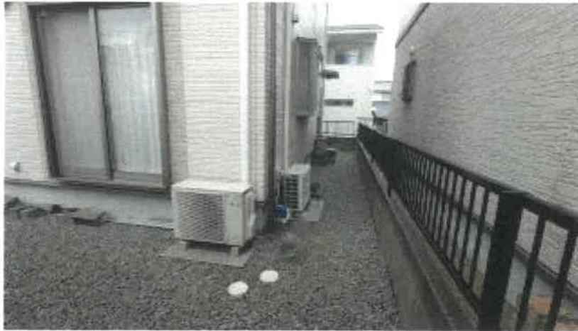
本件物件の北東側の状況
