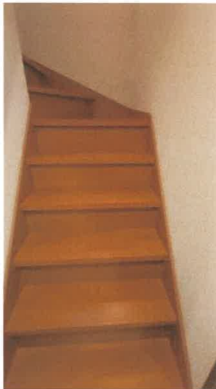
物件 2 階段の状況
