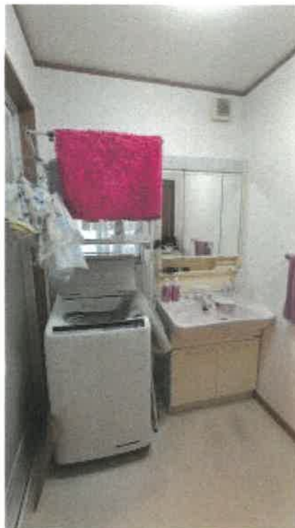
物件2 1階洗面所・脱衣所の状況
