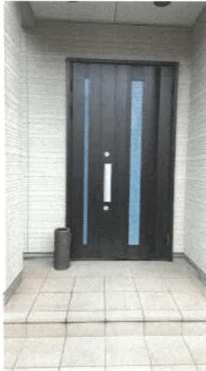
物件 2 玄関付近の状況
