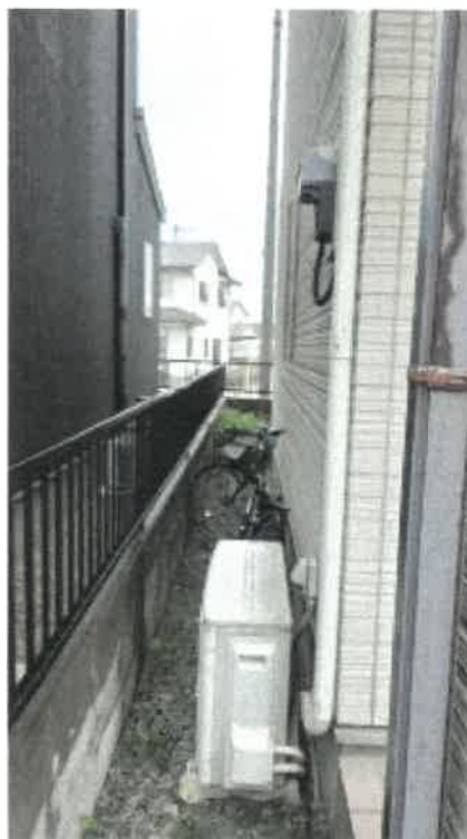
本件南西側の状況
