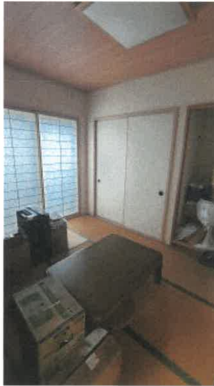
物件 2 1 階和室の状況
