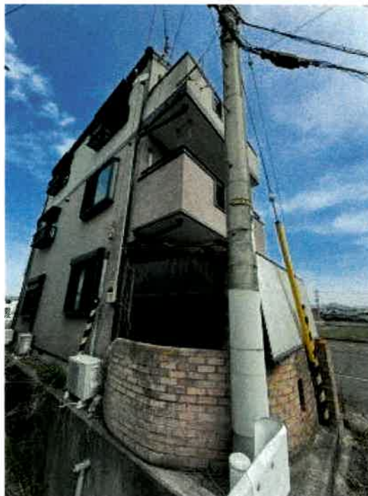
物件 1、3 南西側の状況
