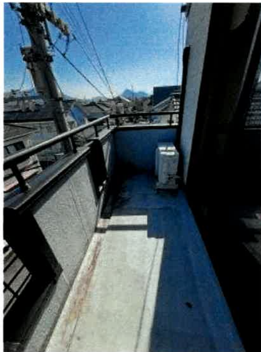
物件3 3階南側バルコニーの状況
