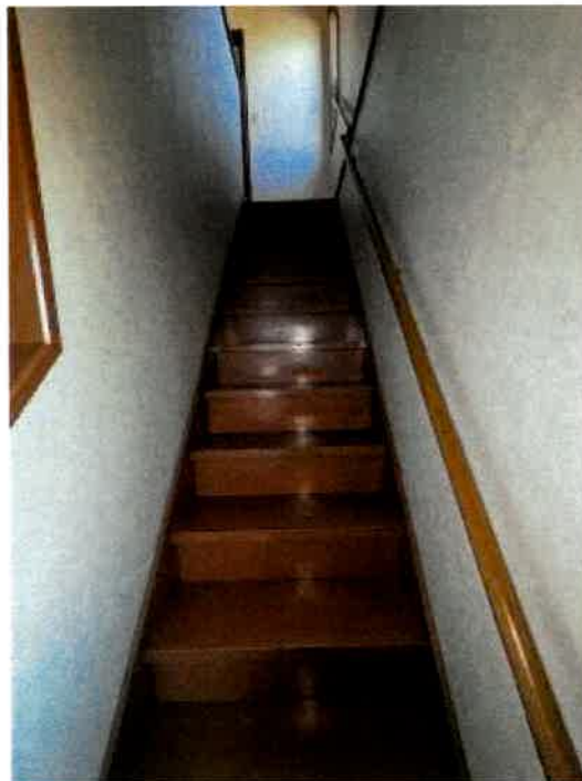
物件3 1階階段の状況
