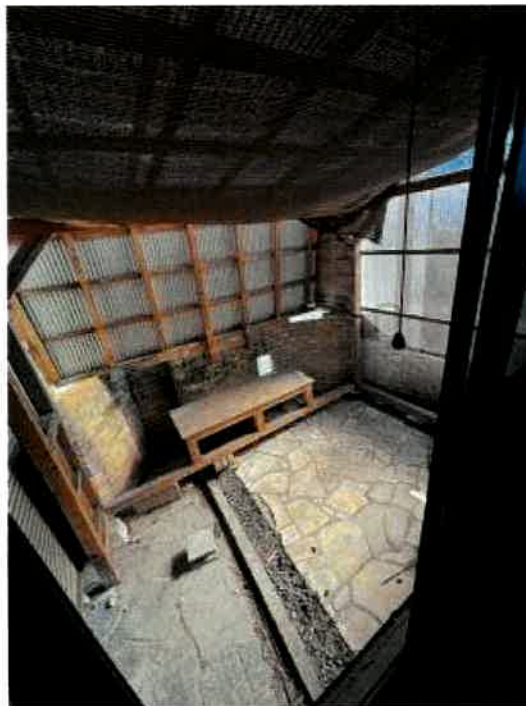
物件3 下屋内の状況
