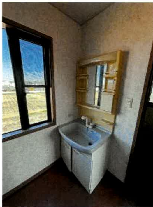
物件3 3階手洗の状況
