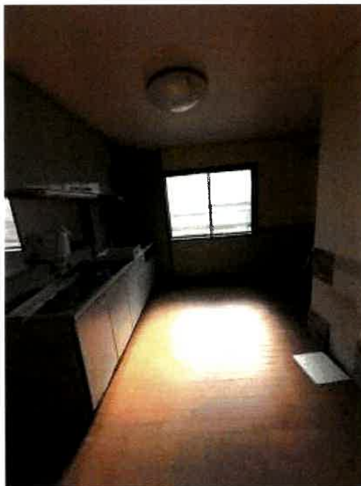
物件3 2階台所の状況
