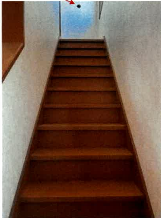
物件3 2階階段の状況
