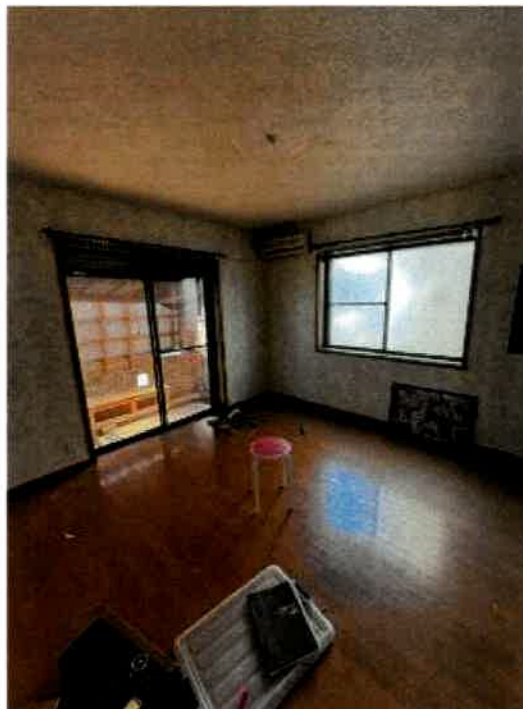
物件3 1階南側洋室の状況
