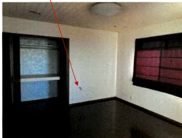
物件3 3階北西側洋室の状況
