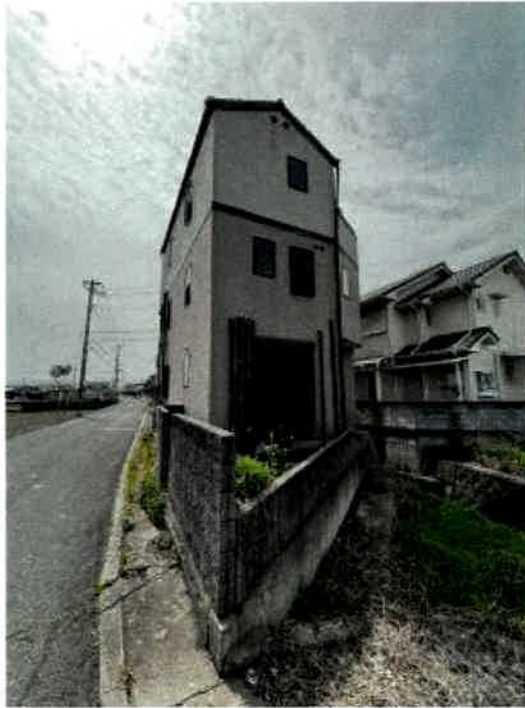
物件 1、3 北東側の状況
