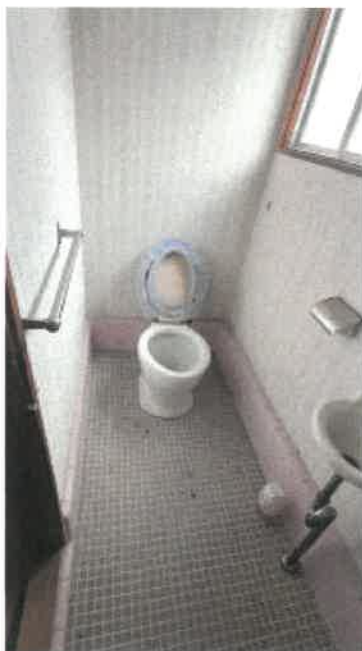
物件 2 建物の便所の状況
