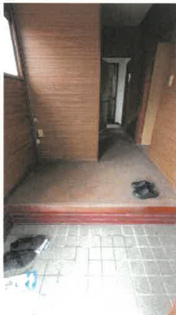
物件 2 建物の土間・廊下の状況
