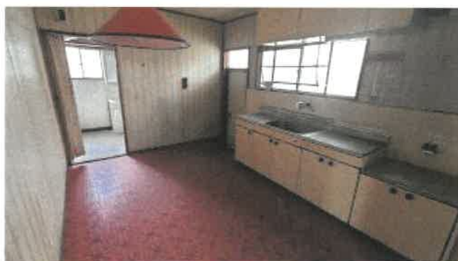
物件 2 建物のキッチン・台所・食堂の状況
