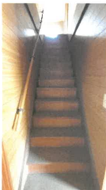
物件2建物の階段の状況
