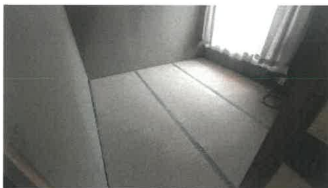
物件 2 建物の 2 階西側和室の状況
