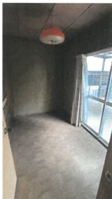
物件2建物の1階板間の状況
