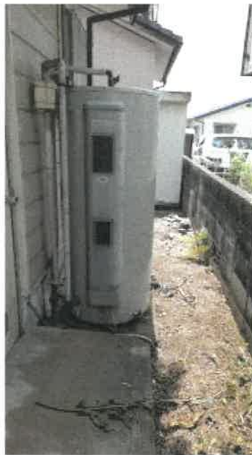
物件 1 土地北側電気温水器の状況
