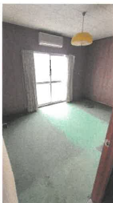
物件 2 建物の 2 階洋室の状況
