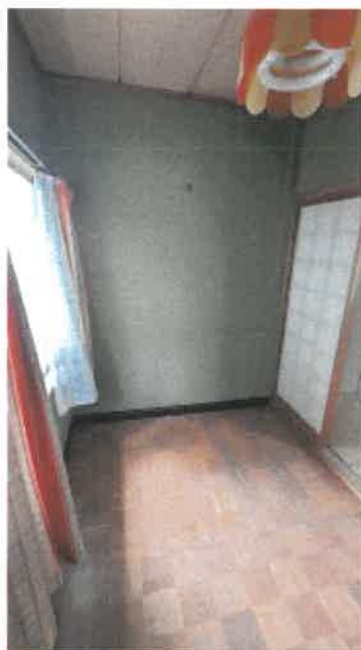
物件 2 建物の 2 階板間の状況
