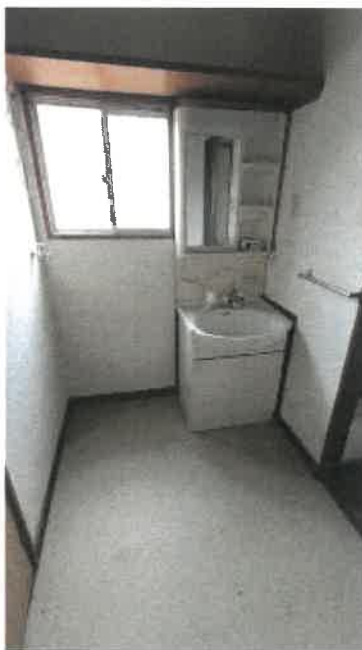
物件 2 建物の洗面・脱衣所の状況
