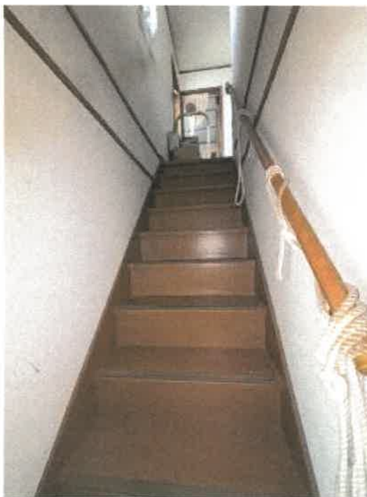
物件3 階段の状況
