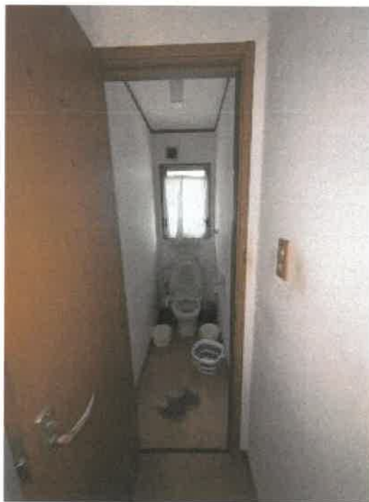
物件3 2階トイレの状況
