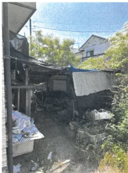
物件1 南側の状況
