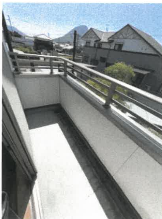
物件3 2階バルコニーの状況
