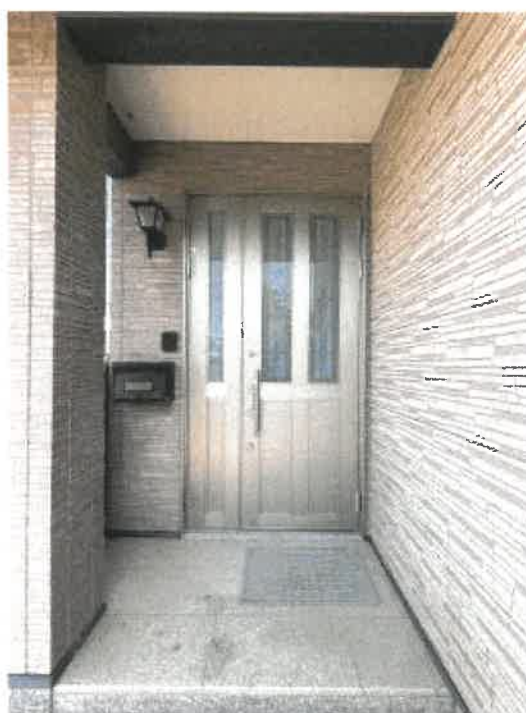
物件3 玄関付近の状況
