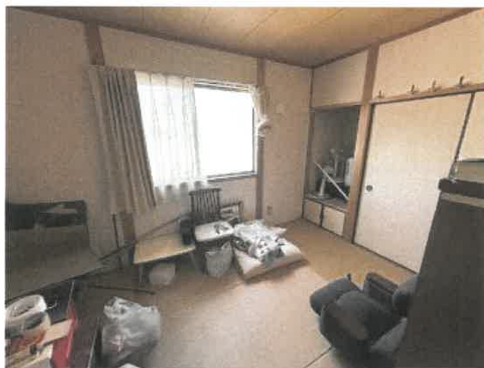
物件3 1階和室の状況
