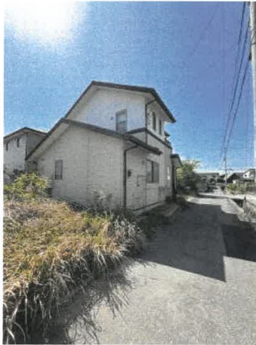
物件 1、2 北西側の状況
