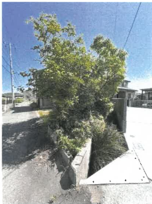
物件 1、2 南西側の状況
