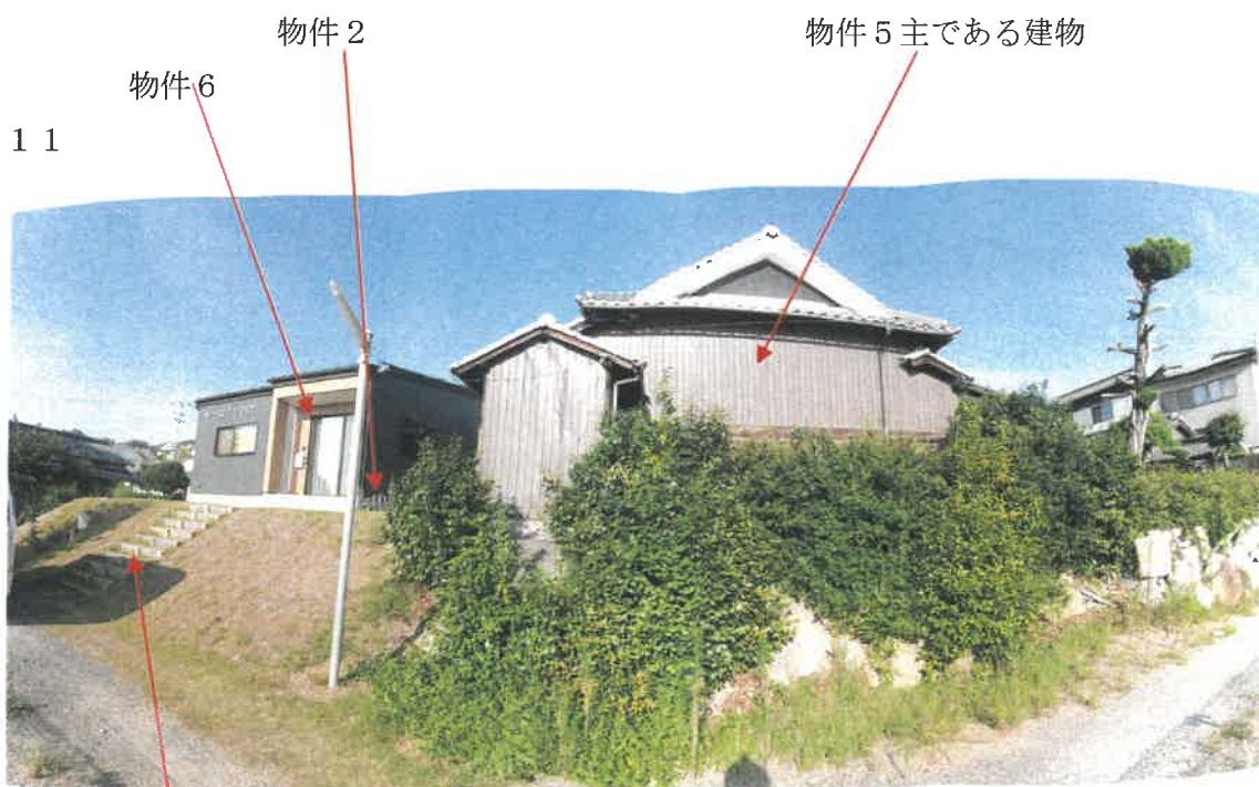
物件 5 主である建物及び物件 6 西側の状況
