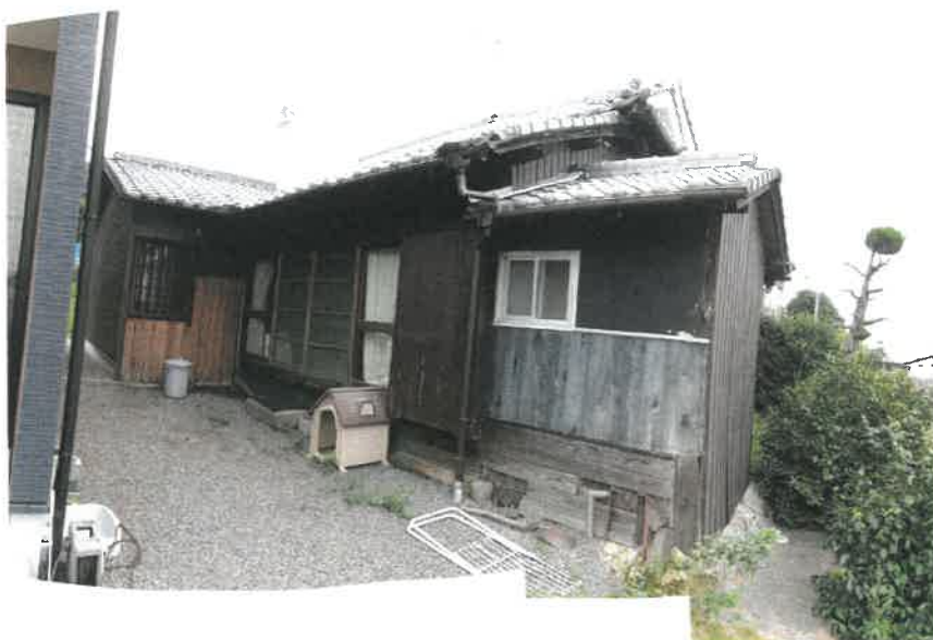
物件 5 主である建物北西側の状況
