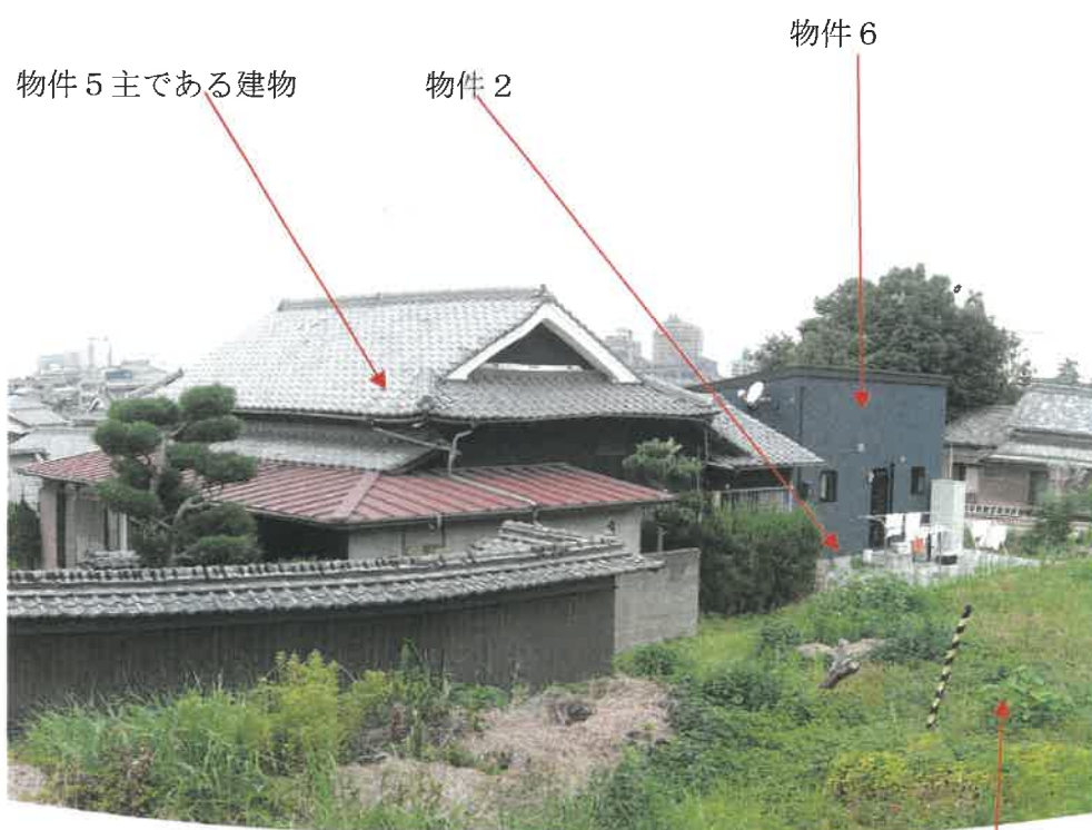
物件2土地東側境界付近の状況
