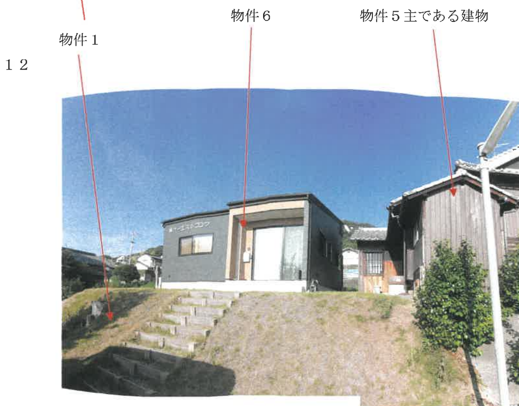
物件 5 主である建物及び物件 6 西側の状況
