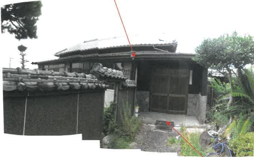
物件5主である建物の南側の状況
