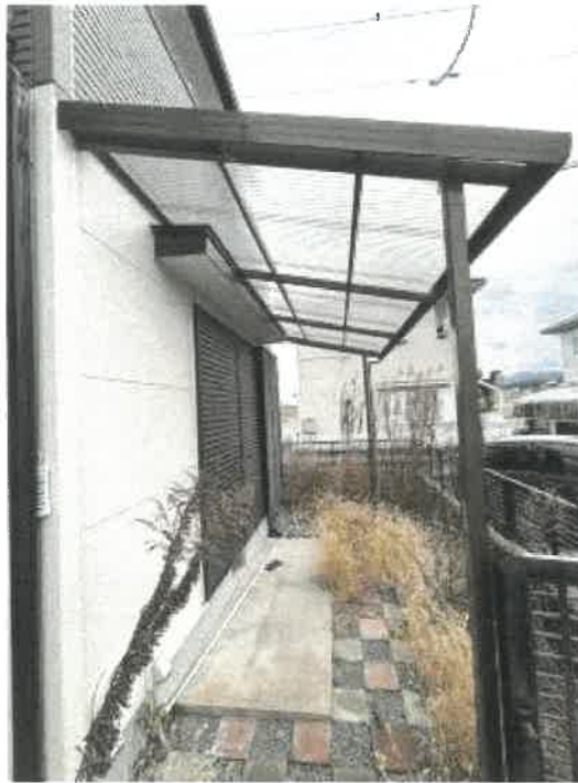
物件1 南東側の状況
