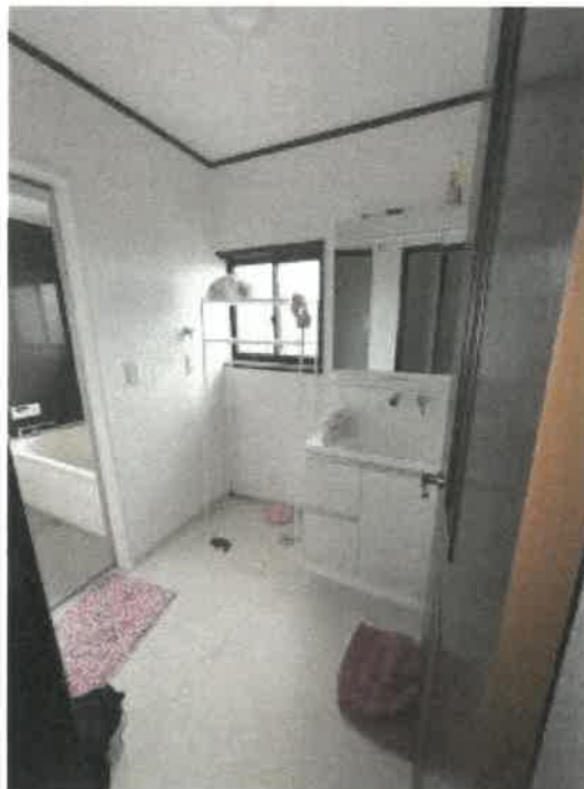
物件2 1階洗面脱衣所の状況
