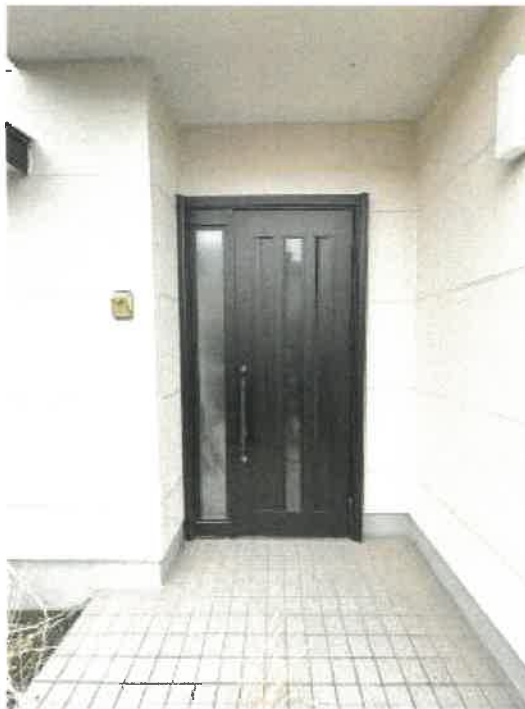
物件2 玄関付近の状況
