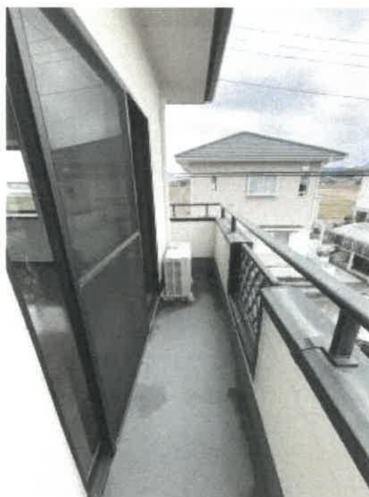
物件2 ベランダの状況
