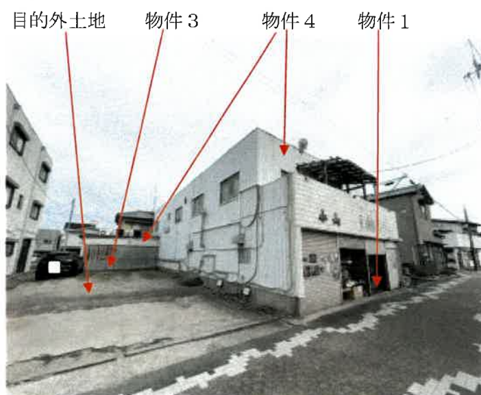
物件1 北西側の状況
