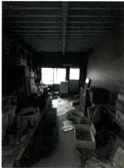
物件 4 2階物置南西側の状況
