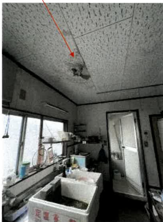
物件4 2階東側台所の状況
