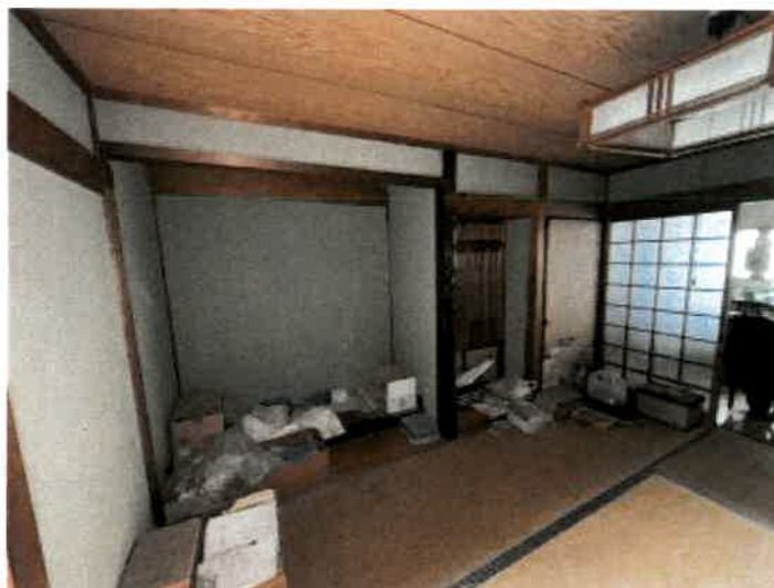
物件 4 2階南側和室の状況
