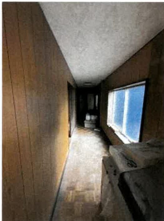
物件 4 2階廊下の状況
