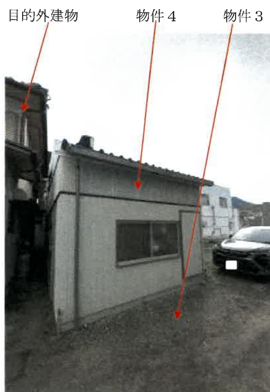
物件3 北東側の状況
