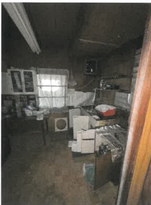
物件6 居宅部分1階台所食堂の状況
