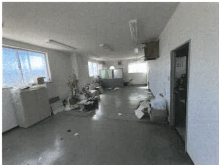
物件6 2階南西側事務室の状況
