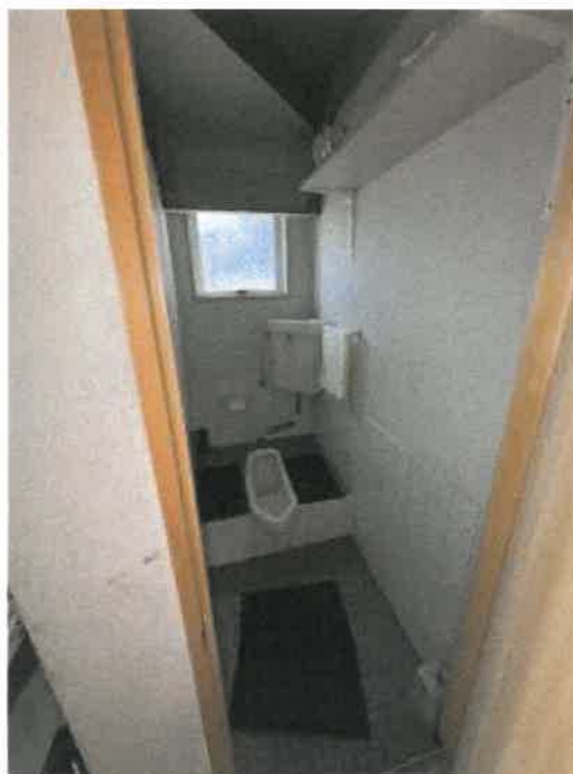
物件6 1階階段下トイレの状況
