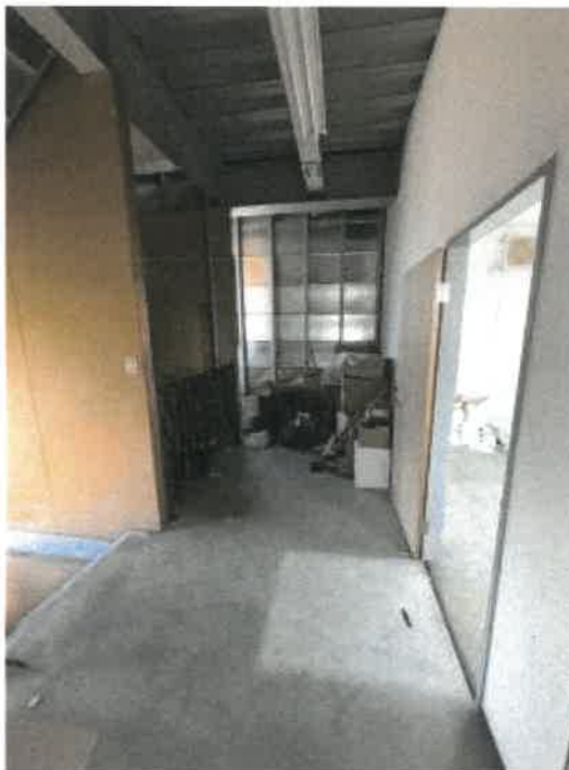
物件 6 2階ホールの状況
