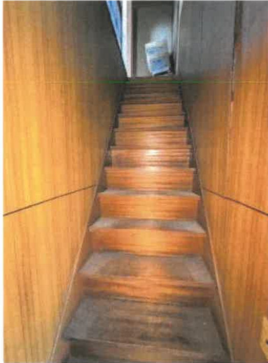
物件 6 居宅部分階段の状況
