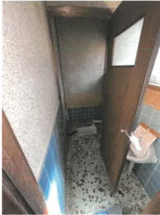
物件6 居宅部分1階トイレの状況
