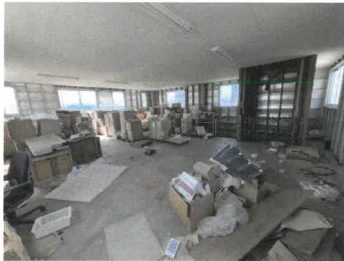
物件6 3階倉庫の状況
