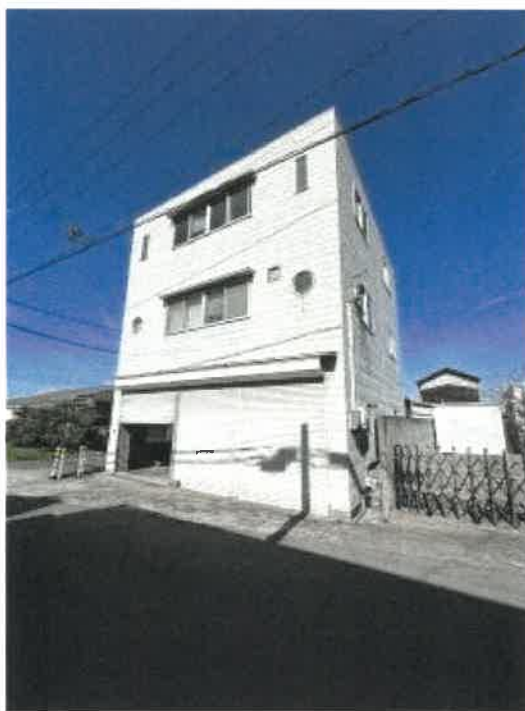
本件物件南西側の状況
