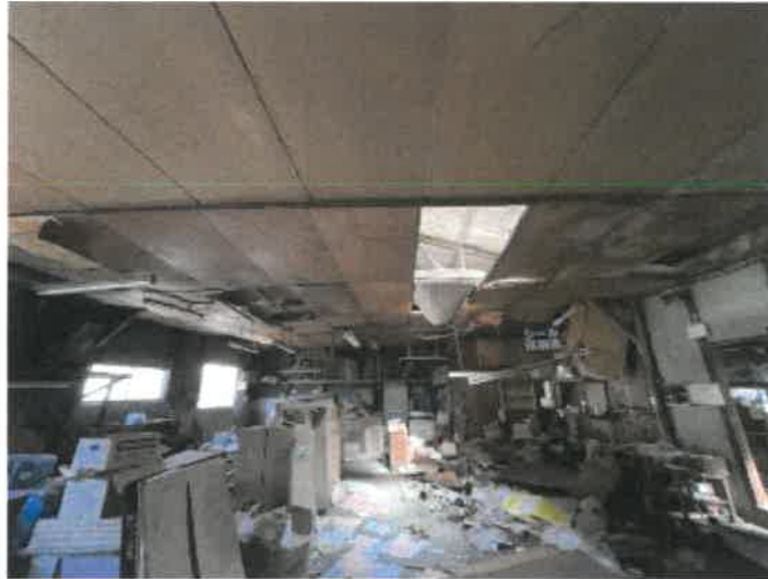
物件6 1階工場中央付近の状況
