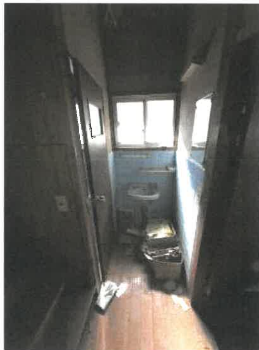
物件6 居宅部分1階手洗の状況
