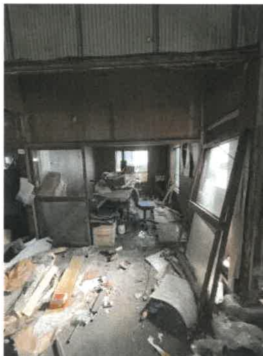
物件6 1階工場内事務室の状況
