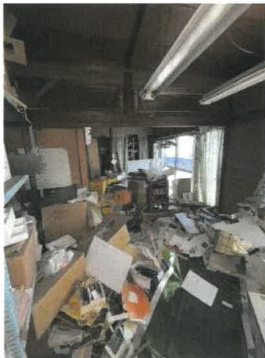
物件6 居宅部分1階南西側和室の状況
