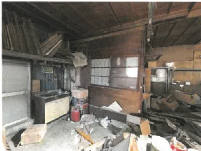
物件6 1階東側付近の状況
