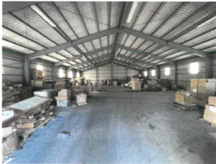
物件 8 倉庫内の状況
