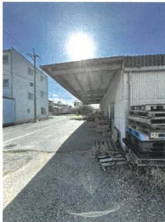
物件8 下屋の状況
