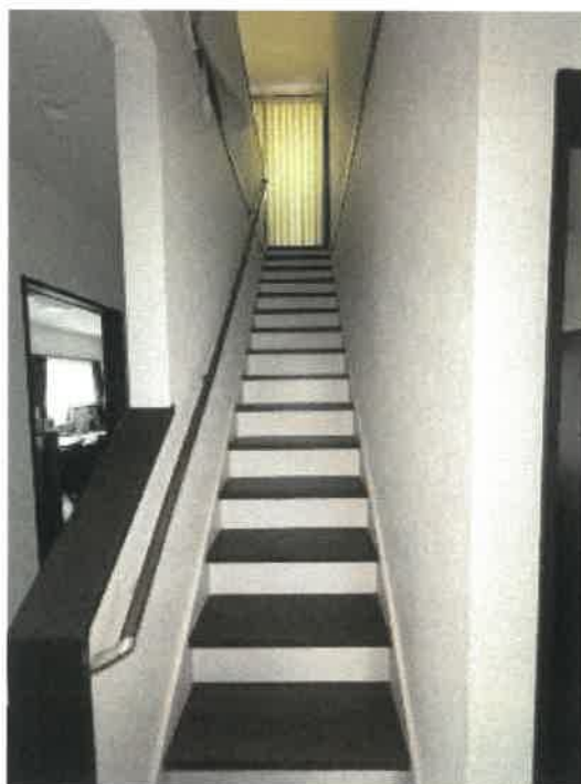
物件2 階段の状況
