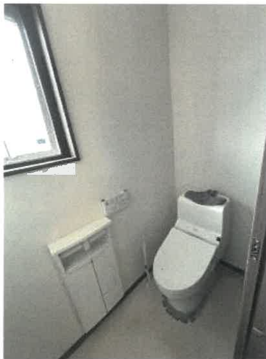
物件2 2階トイレの状況
