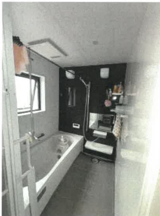
物件2 1階浴室の状況
