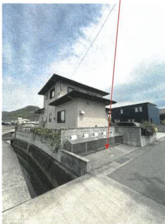
物件1 北西側の状況
