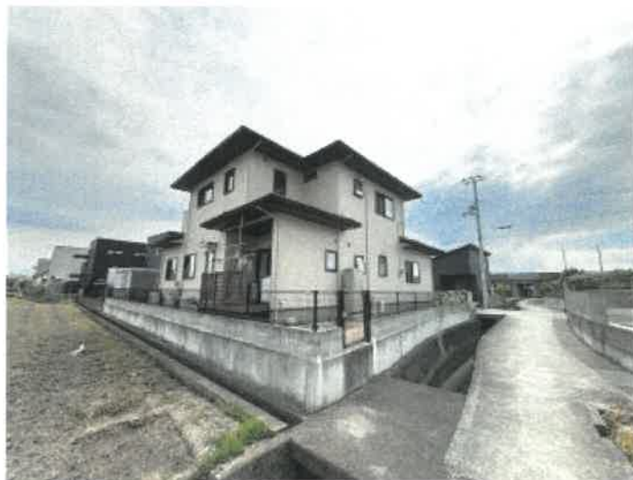
物件1 北東側の状況
