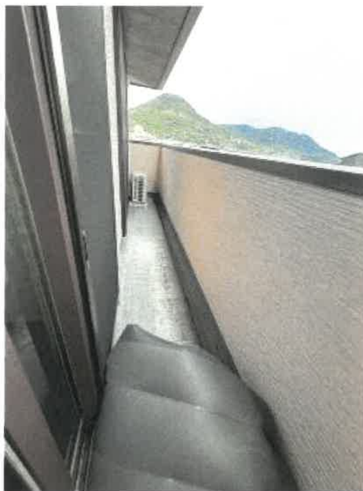
物件2 バルコニーの状況
