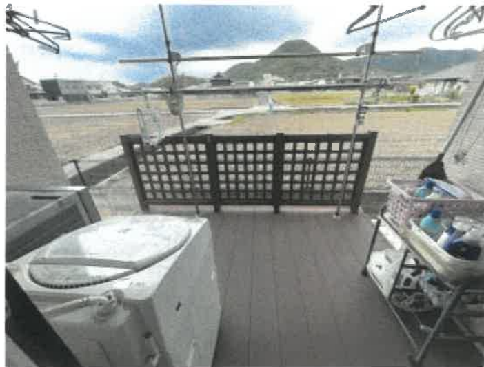
物件2 ウッドデッキの状況
