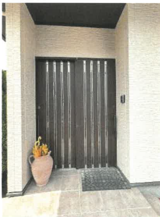
物件2 玄関の状況
