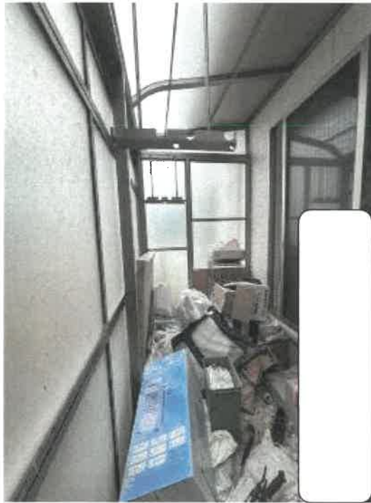
物件2 サンルーム内の状況
