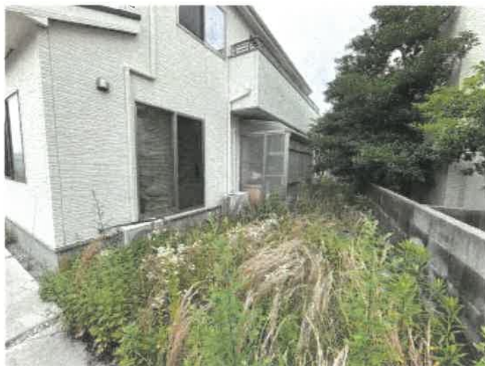
物件1 南側の状況
