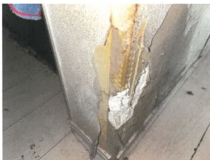
物件2 1階台所カウンターの状況
