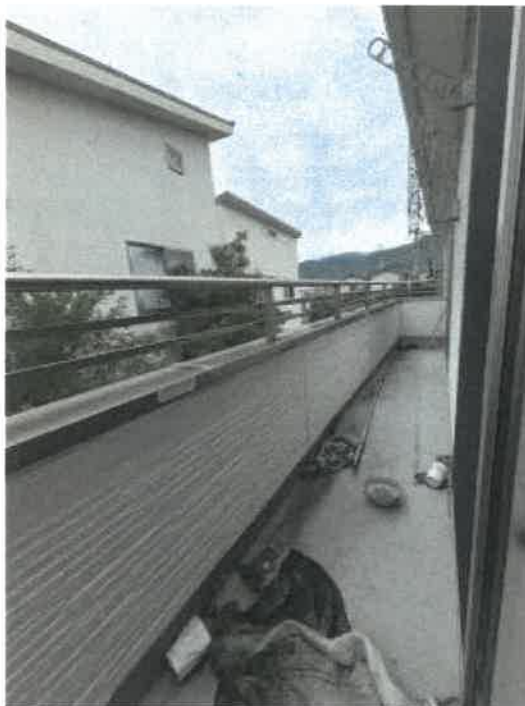
物件 2 バルコニーの状況
