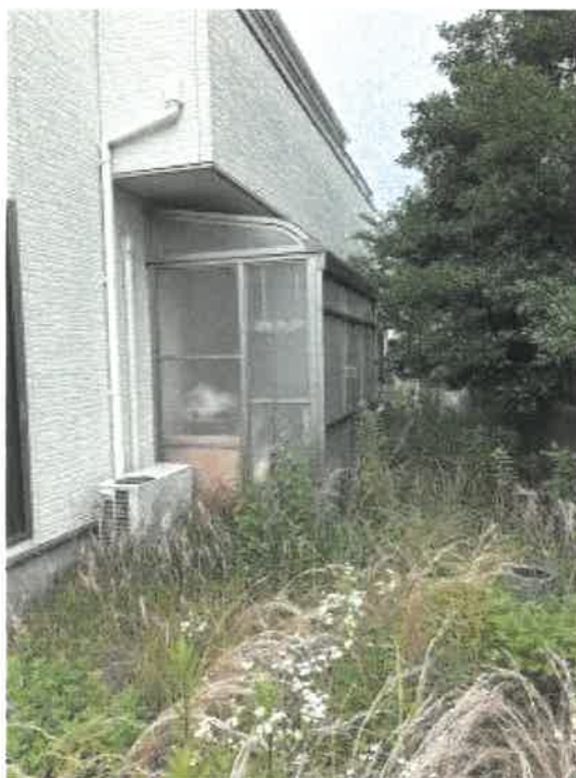
物件2 サンルームの状況
