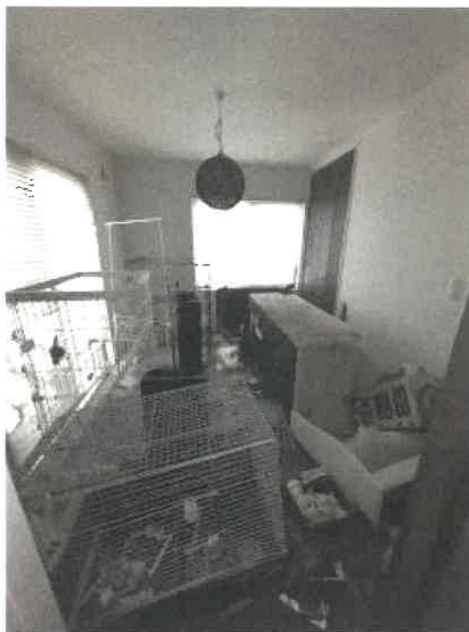
物件2 1階和室の状況
