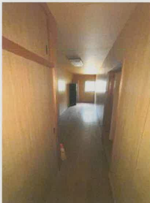
平家建部分北側物置の状況
