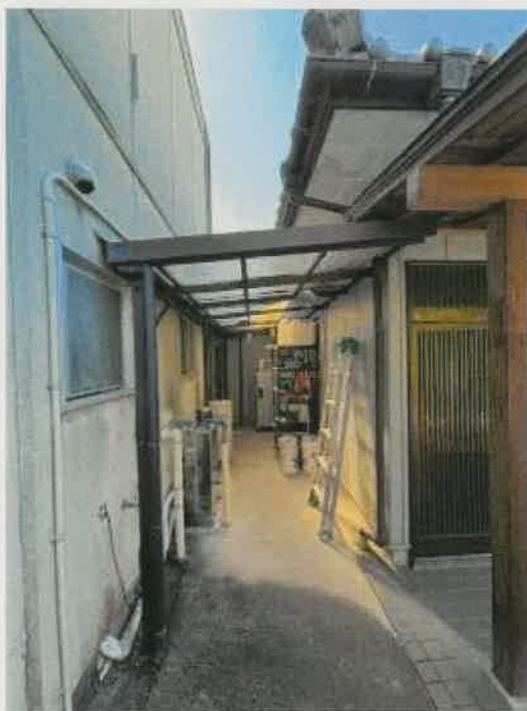
平家建部分玄関南西側の状況
