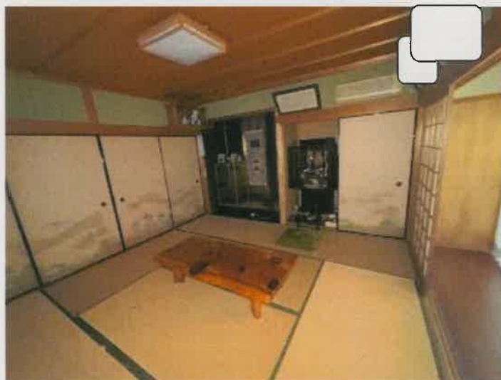
平家建部分北東側和室の状況
