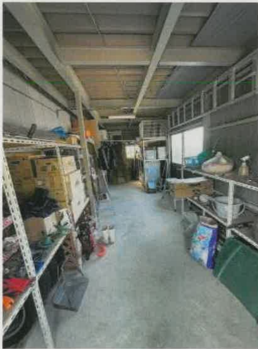
未登記増築部分（倉庫）内の状況
