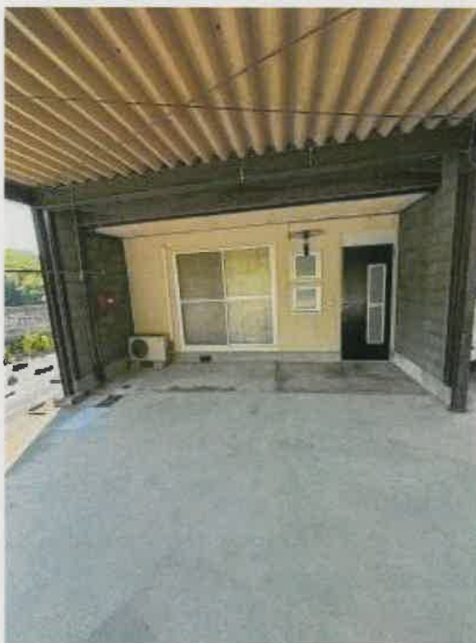
2階建部分玄関付近の状況
