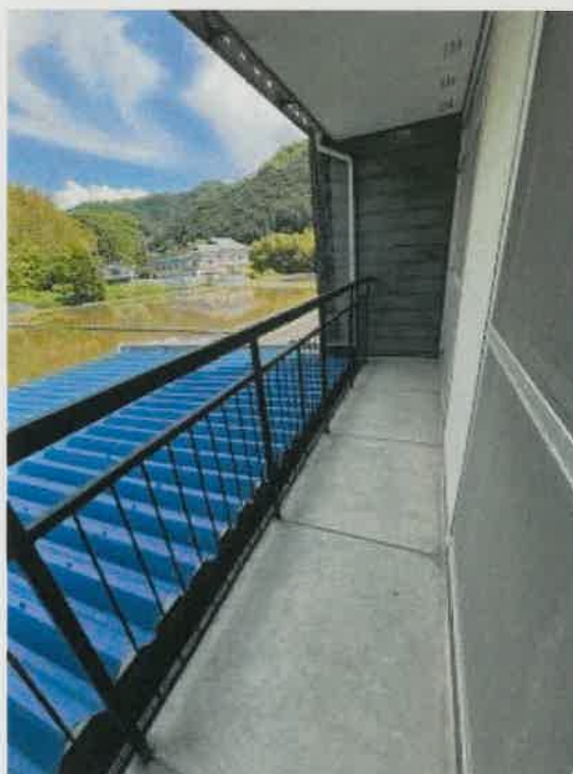
2階建部分 2階ベランダの状況
