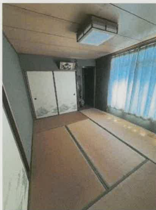
2階建部分 2階西側和室の状況
