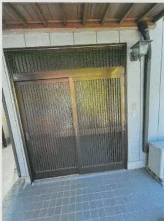
平家建部分玄関付近の状況
