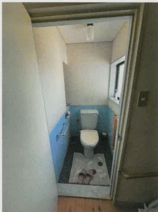
トイレ（洋式）の状況
