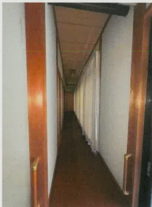
平家建部分縁側の状況
