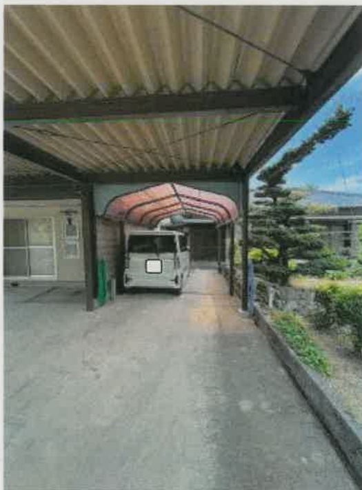
カーポート北東側の状況
