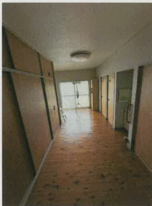
平家建部分南西側ホールの状況
