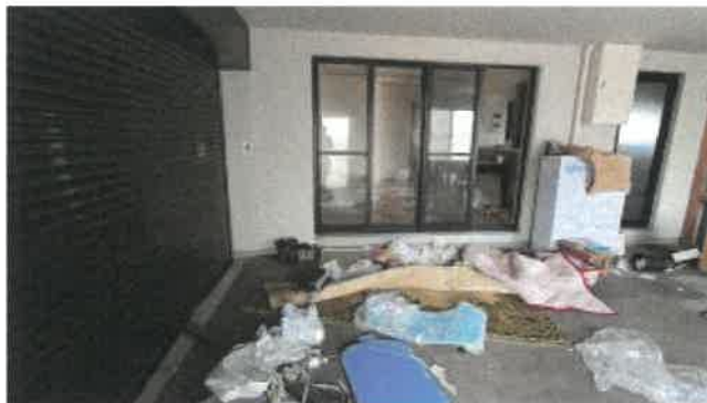
物件2 1階車庫シャッターの状況
