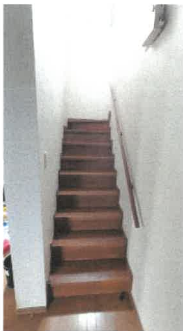
物件 2 階段の状況
