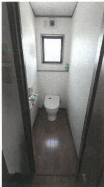
物件2 2階便所の状況
