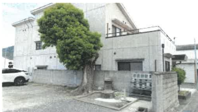
本件物件西側隣接地からの状況
