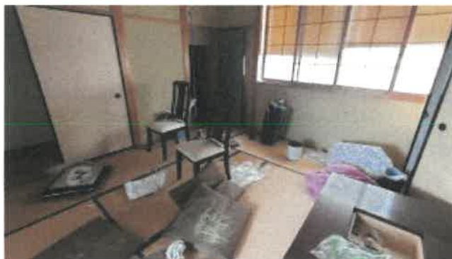
物件 2 1 階和室の状況
