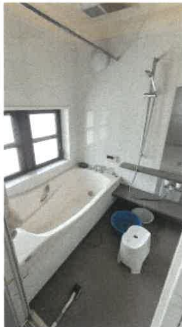
物件2 2階浴室の状況
