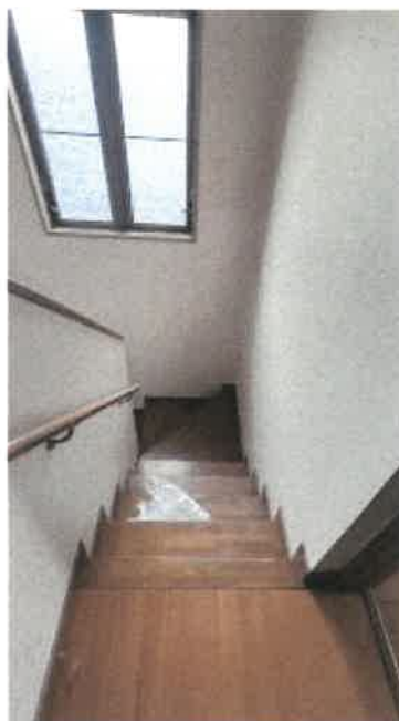
物件 2 階段の状況
