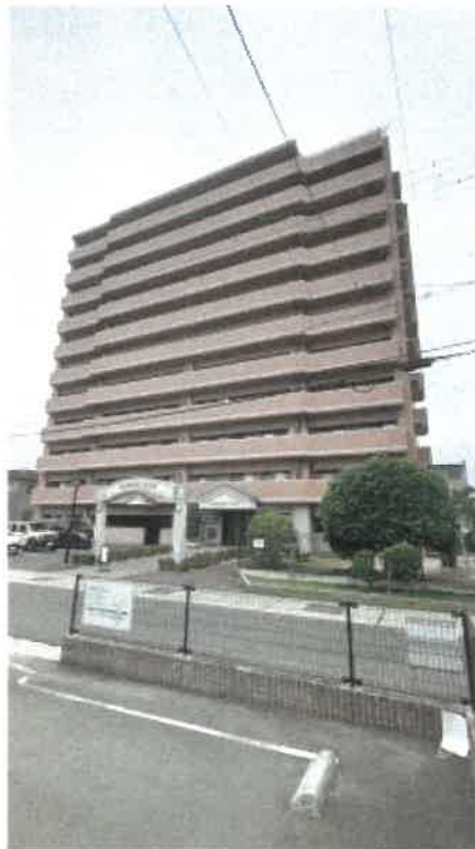
本件マンションの外観
