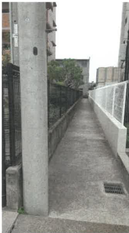
本件敷地東側の状況
