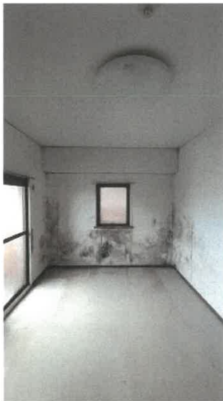
北側洋室の状況
