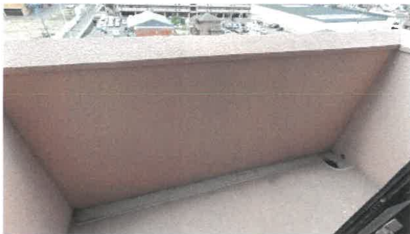
西側洋室バルコニーの状況
