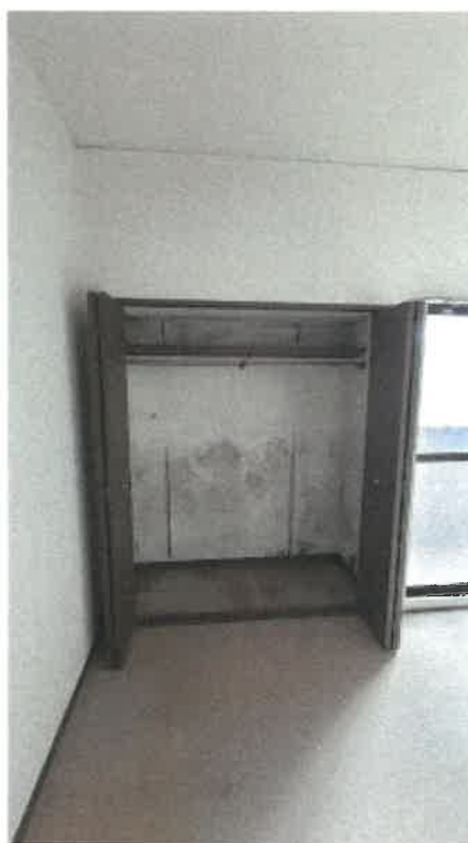
北側洋室の状況
