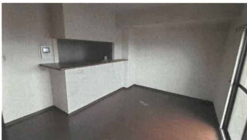
リビング・ダイニングの状況
