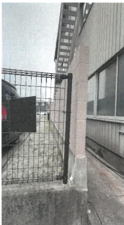
本件敷地北側の状況
