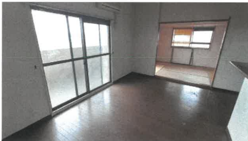
リビング・ダイニングの状況
