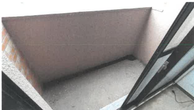
北西側洋室バルコニーの状況
