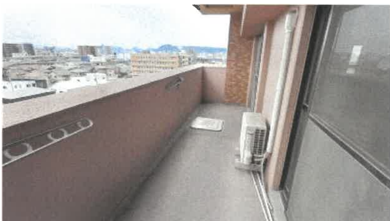
南側バルコニーの状況
