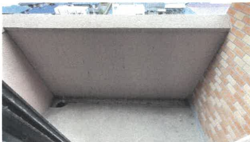
北側洋室バルコニーの状況
