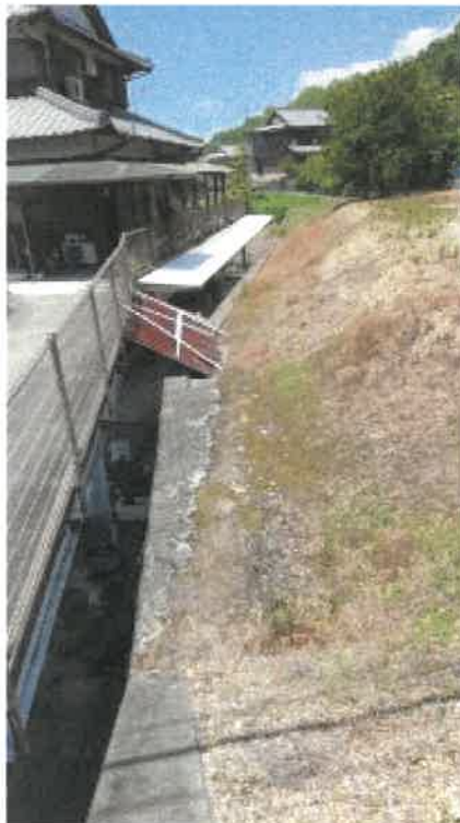
本件物件西側の状況
