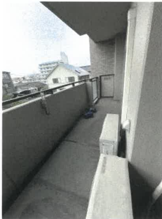
バルコニーの状況
