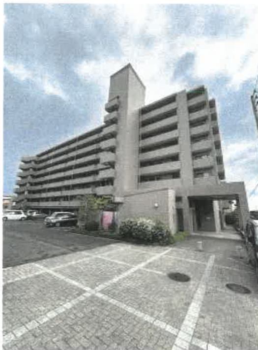
本件マンションの外観
