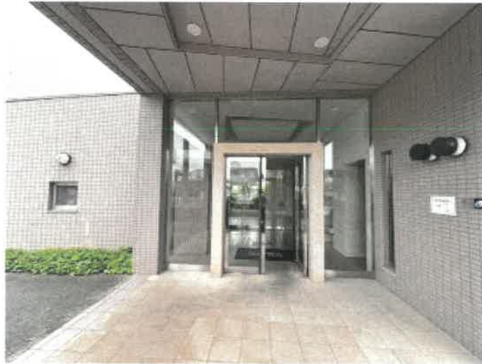
マンション入口付近の状況
