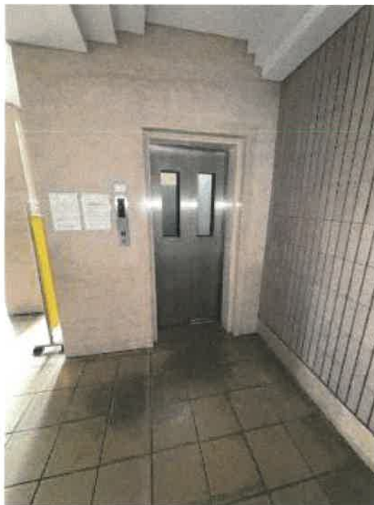
エレベーターの状況
