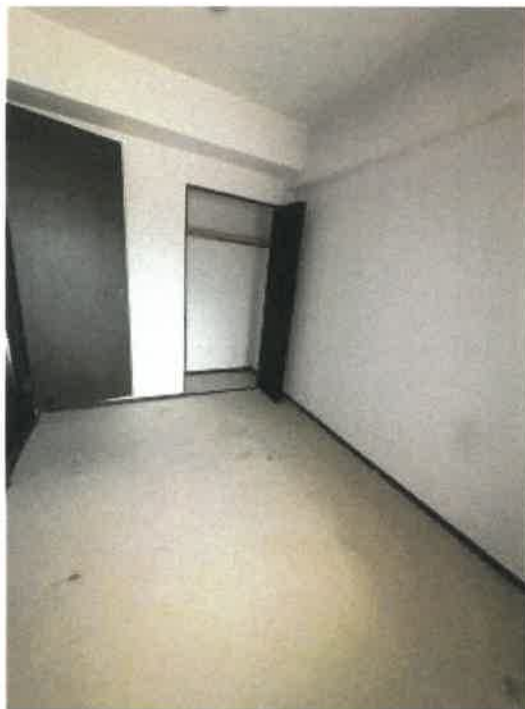
北西側洋室の状況
