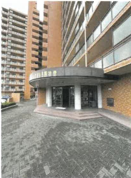
本件マンションの入口付近の状況
