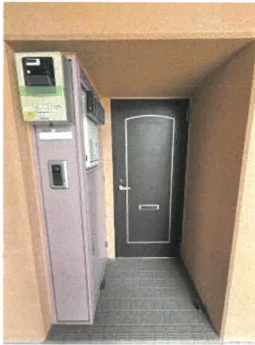
本件物件玄関付近の状況
