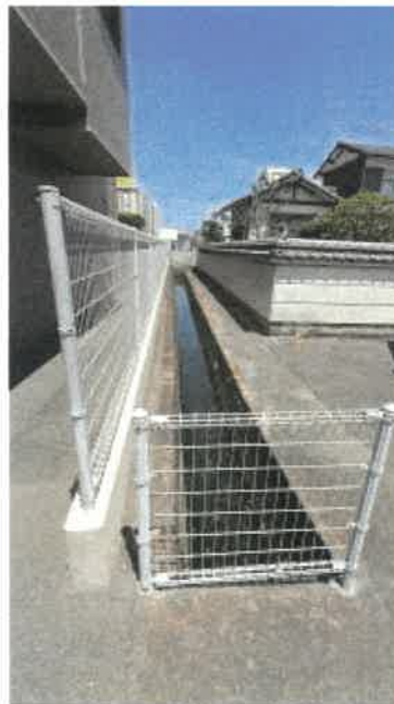
本件敷地北東側の状況
