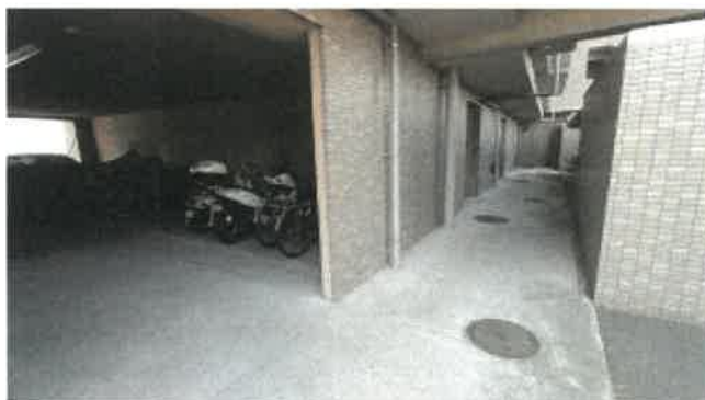
駐輪場の状況
