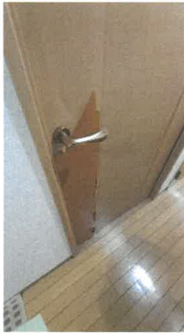
北東側洋室扉の状況
