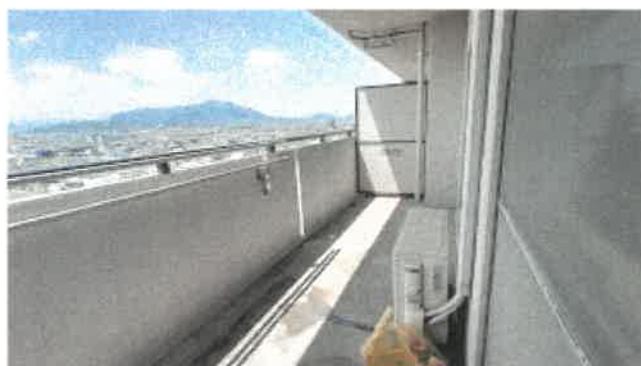
バルコニーの状況
