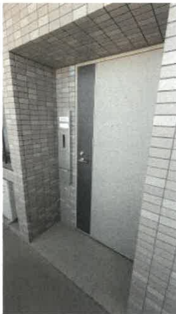
玄関付近の状況
