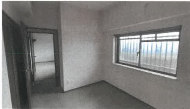
東側洋室の状況
