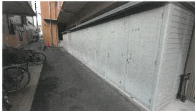
本件敷地北側の状況
