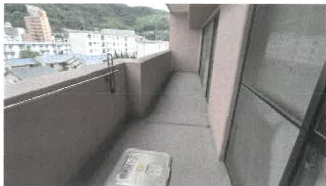
バルコニーの状況
