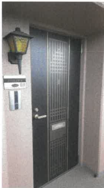
玄関付近の状況
