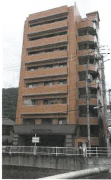
本件マンションの外観
