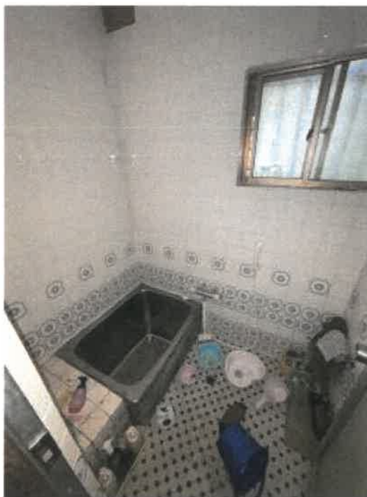
物件2 1階浴室の状況
