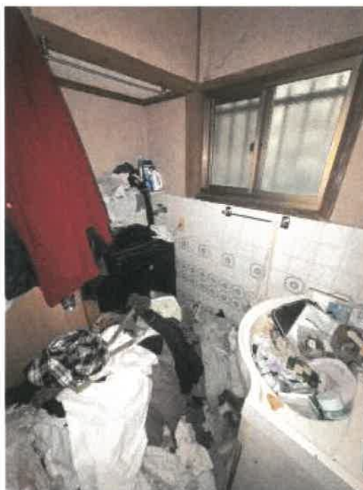
物件2 1階洗面脱衣所の状況
