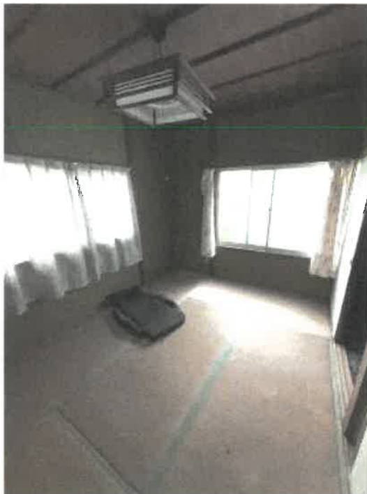
物件2 2階和室の状況
