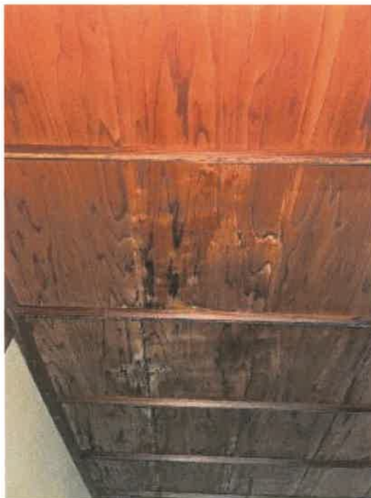
物件2 2階和室の天井の状況
