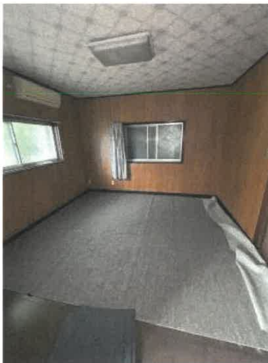
物件 2 2階洋室の状況
