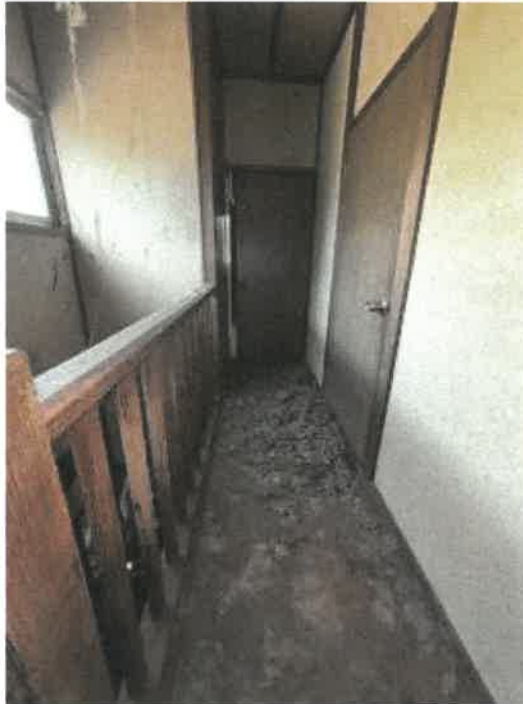
物件 2 2階廊下の状況
