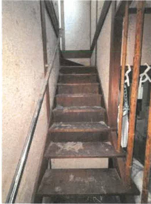
物件 2 階段の状況
