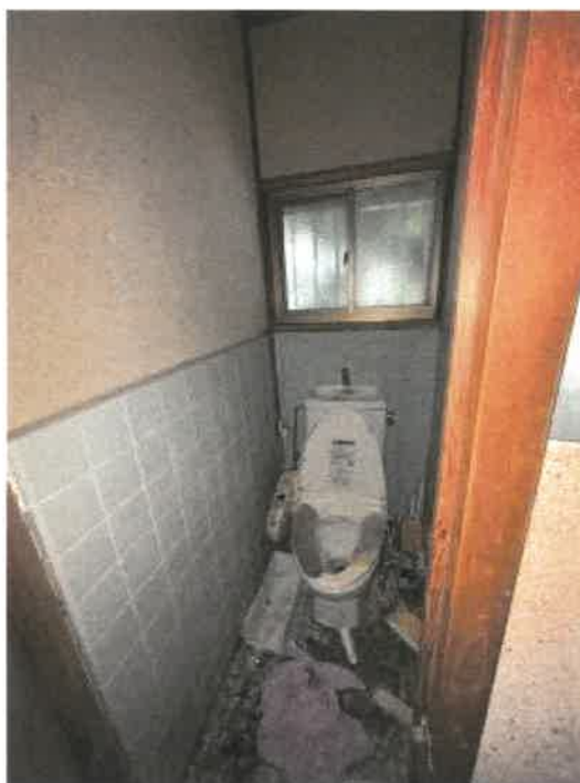
物件2 1階トイレの状況
