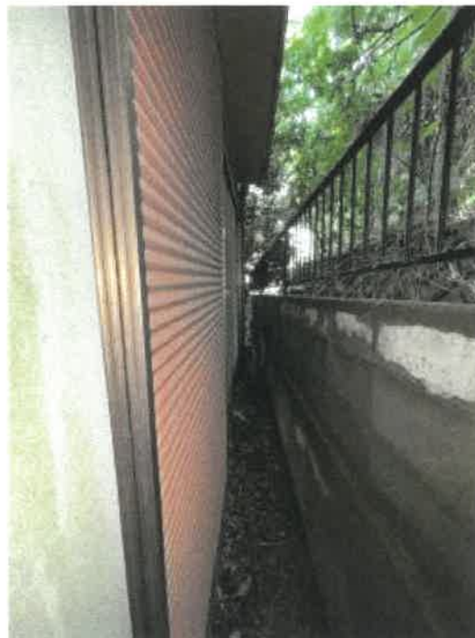
物件1 南側の状況
