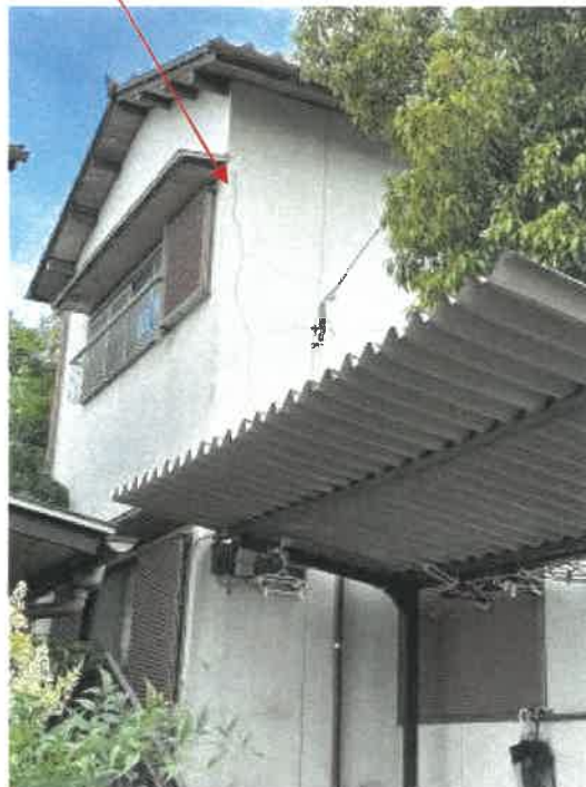
物件2 北東側の状況
