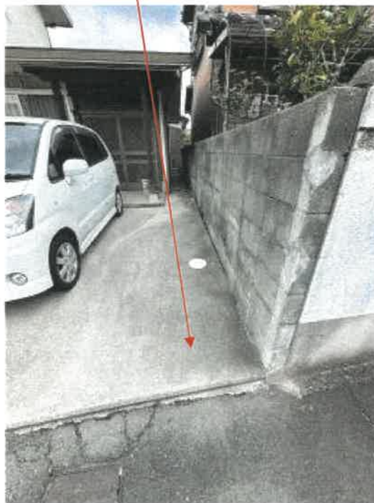
物件 2 南東側の状況
