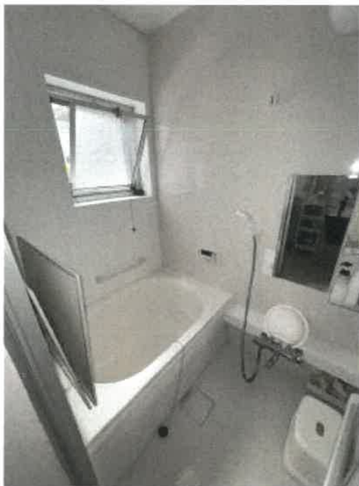
物件3 1階浴室の状況
