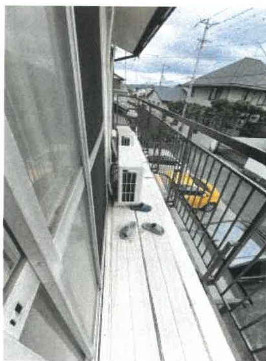
物件3 バルコニーの状況
