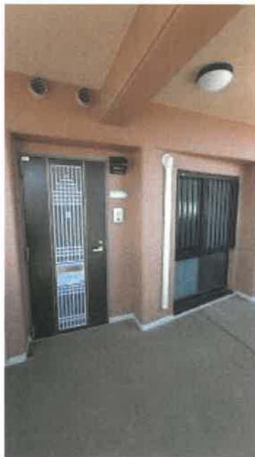
玄関付近の状況
