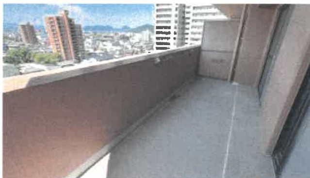
南側バルコニーの状況
