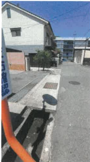
本件敷地北側の状況
