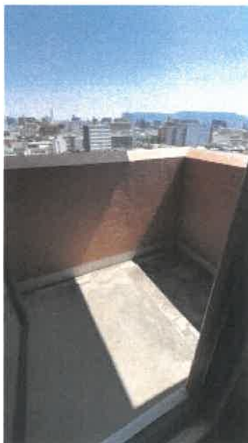
北側バルコニーの状況
