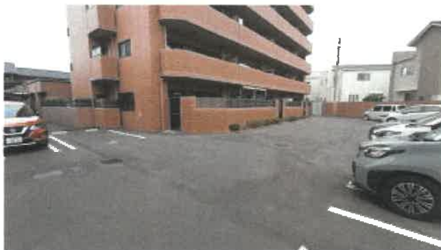
本件敷地南側駐車場の状況
