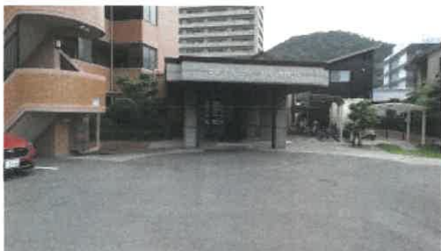
本件マンションのポーチの状況
