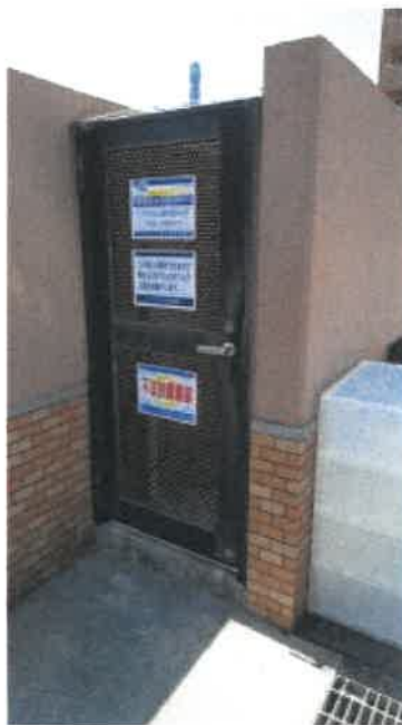
ゴミ置場の状況
