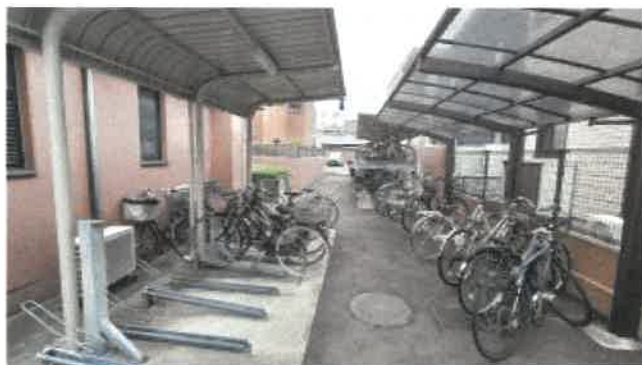
本件敷地西側駐輪場の状況
