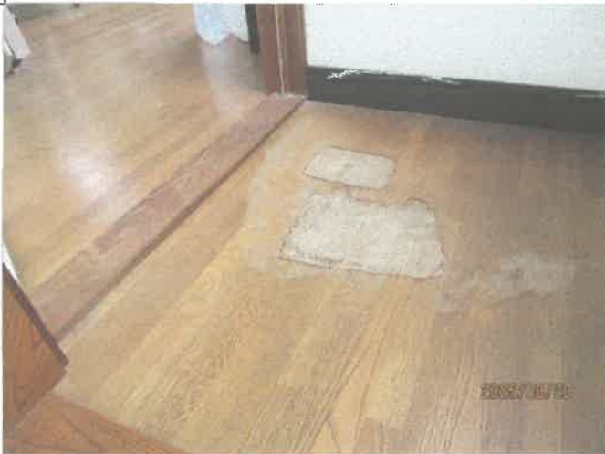
階段下 床の雨染み痕
