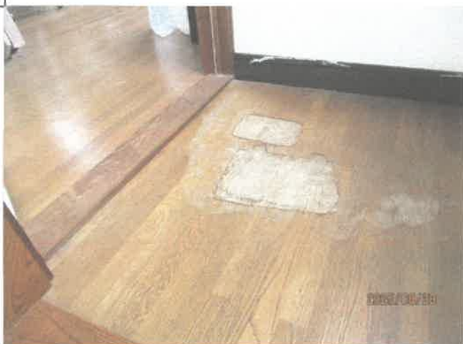
階段下 床の雨染み痕
