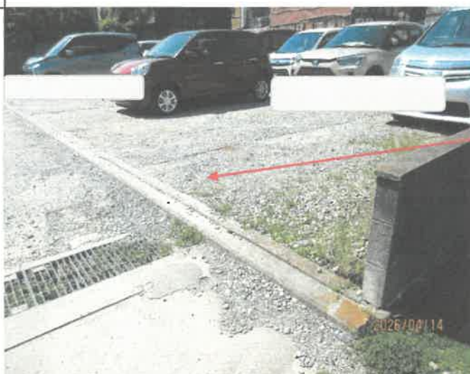
物件1 北側露天駐車場
