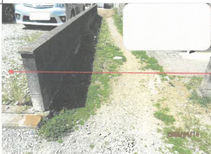
物件1 北側露天駐車場
