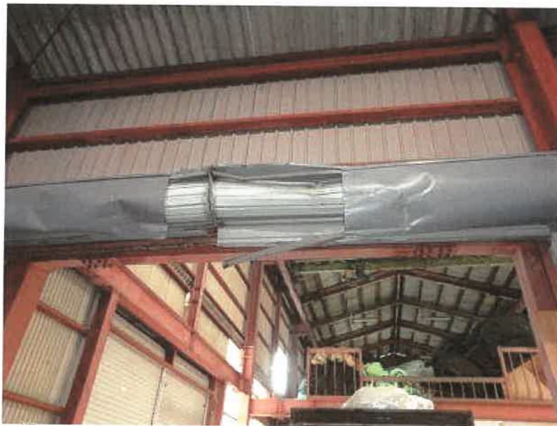
物件17 倉庫④シャッターの状況
