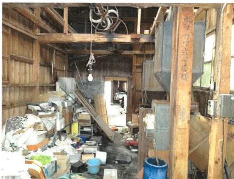
物件 3 未登記附属建物①内（作業所）
