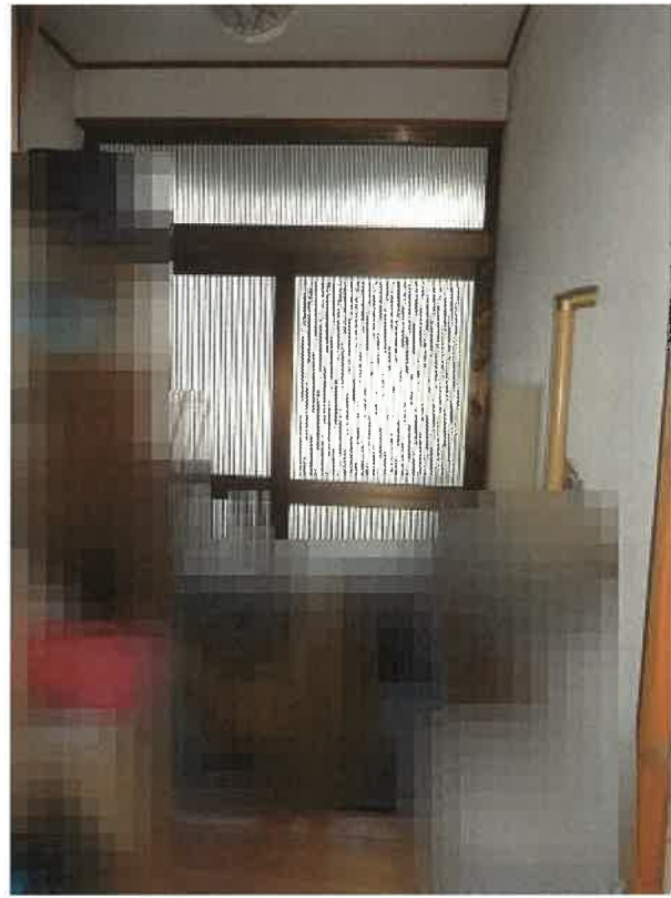
物件3の建物 (1階玄関内) の状況
