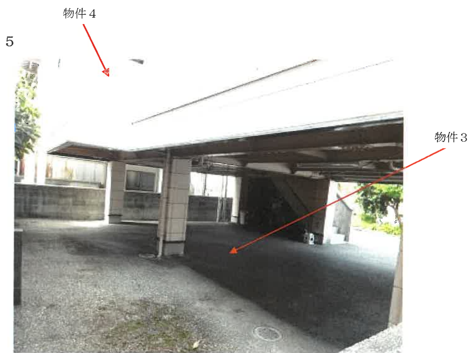
ピロティ（1階下駐車スペース）
