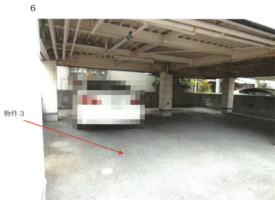
ピロティ（1階下駐車スペース）
